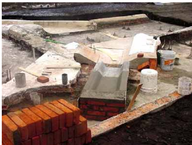
Fig. 4.4 Construcción del canal de margen derecha
