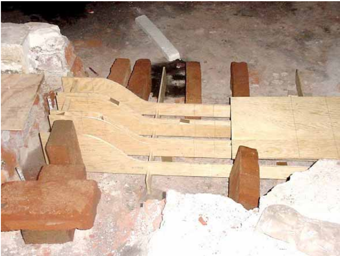
Fig. 4.5 Tarrajas de plantillas y tanque disipador.
