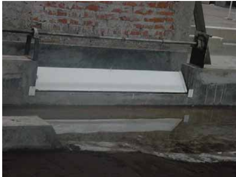
Fig. 2.6 Compuerta tipo abatible.
