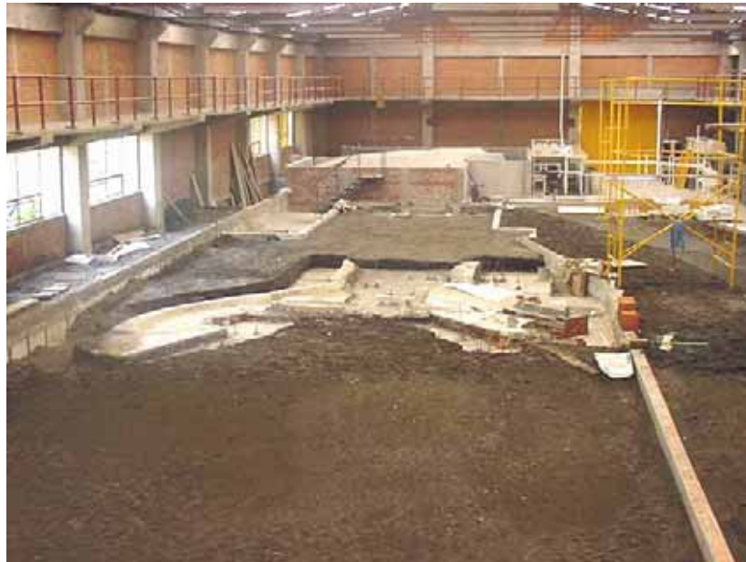
Fig. 4.2 Trabajos de demolición en el modelo
