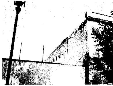
Estructura a base de muros de tabique, tezontle y tepetate, recubiertos con aplanado color ocre por el interior y fachada principal, en ésta última uso de balcones con marcos de cantera y barandales metálicos. Entrepisos a base de vigas de madera de pino. (Entablado). La forma de los entrepisos y cubierta es plana franciscana. El ancho de los muros es de 65 centímetros.
