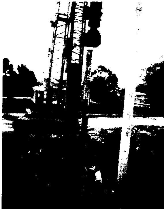
Fotografía 18. Hincado de pilotes con guía.
