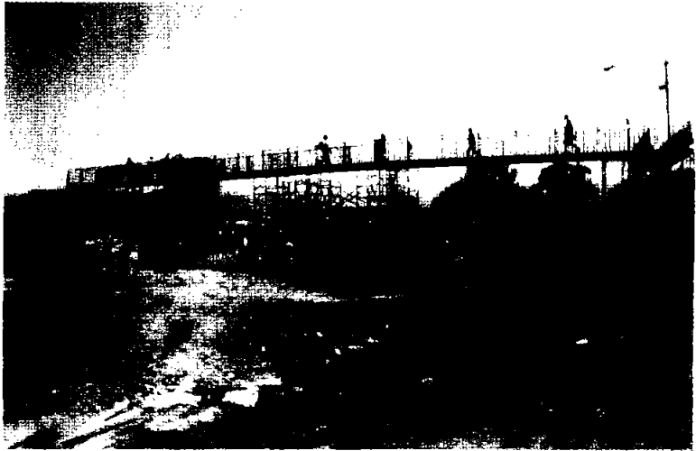
Fotografía 19a. Puente peatonal provisional
