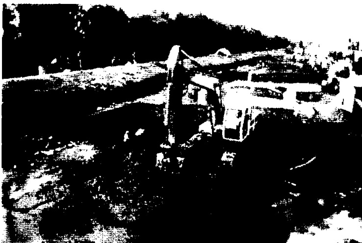
Fotografía 12. Excavación en la zona de aireplén.
