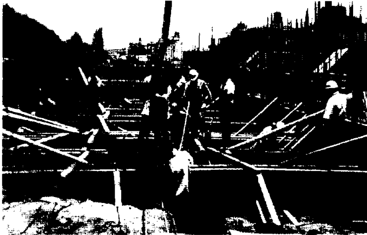
Fotografía 14. Colado de traves en la zona de aireplén.
