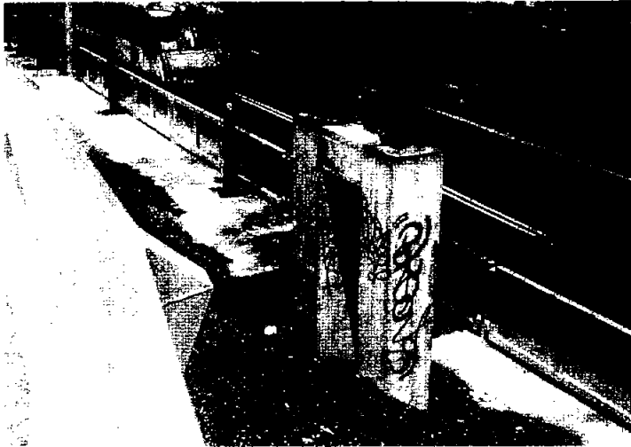
Fotografía 22. Columnas de soporte del puente peatonal.
