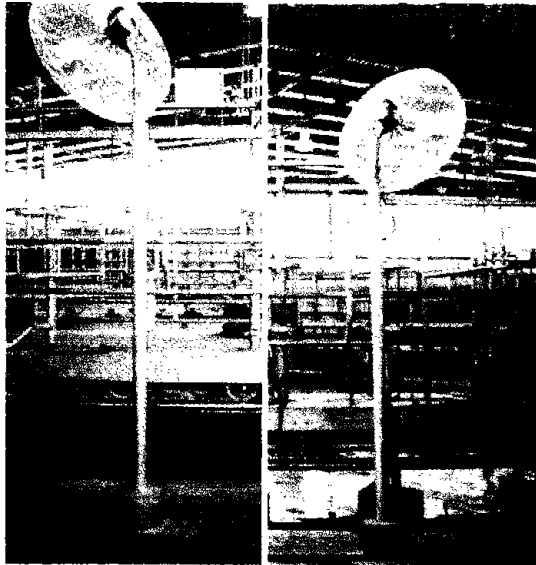
Figura 51. Ventiladores en la sala de ordeño. Cuenca Lagunera, Torreón, Coahuila, Méx.
