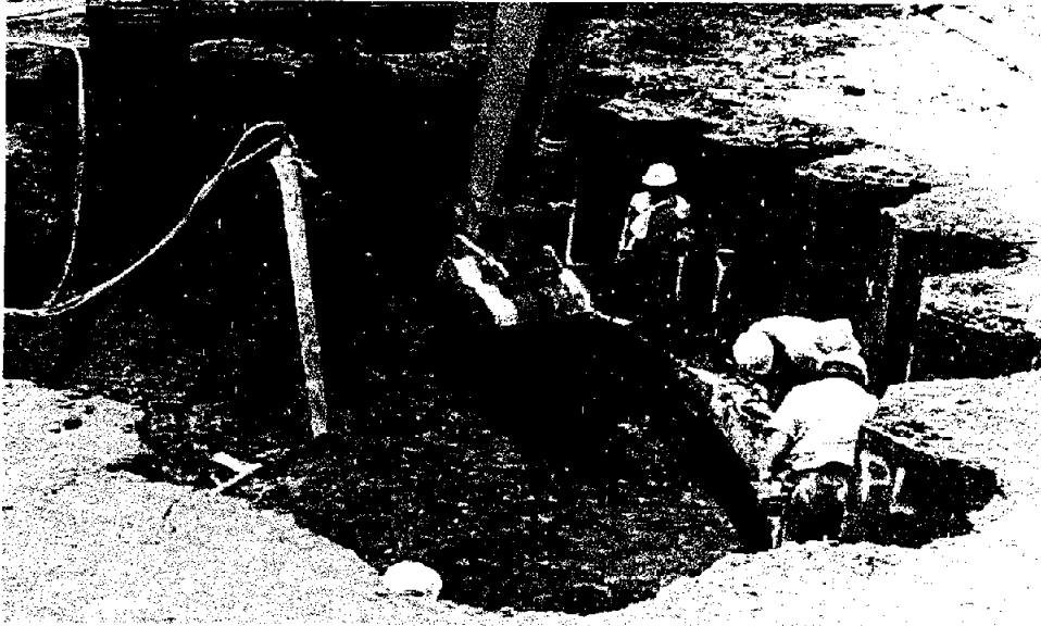
Terminado el hincado de tablestaca a una profundidad de 18 m. se procede la excavación y poder retirar el anillo guía
