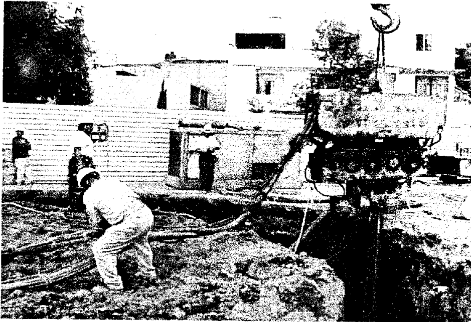
La tablestaca hincada a una profundidad de 18 m.
