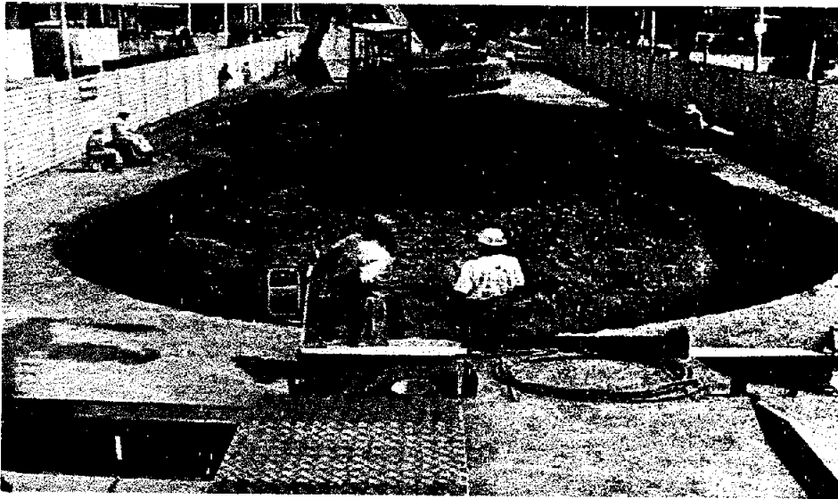
Excavación con retroexcavadora 225 LB en el perímetro de la lumbrera circular.
