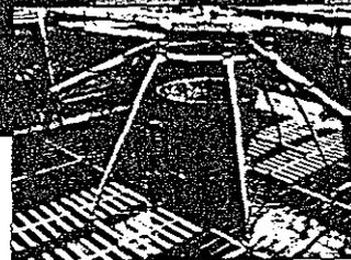
Saneamiento mediante colocación de membranas de aireación de Silicona sobre el cuerpo de soporte existente
