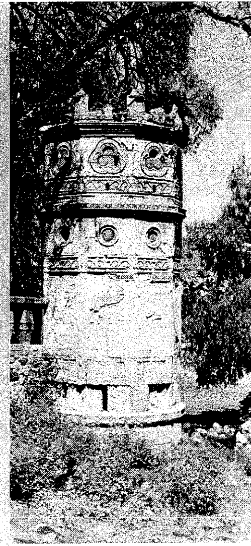
TORREÓN (EN LA PARTE ALTA SE UTILIZA COMO TANQUE ELEVADO)
