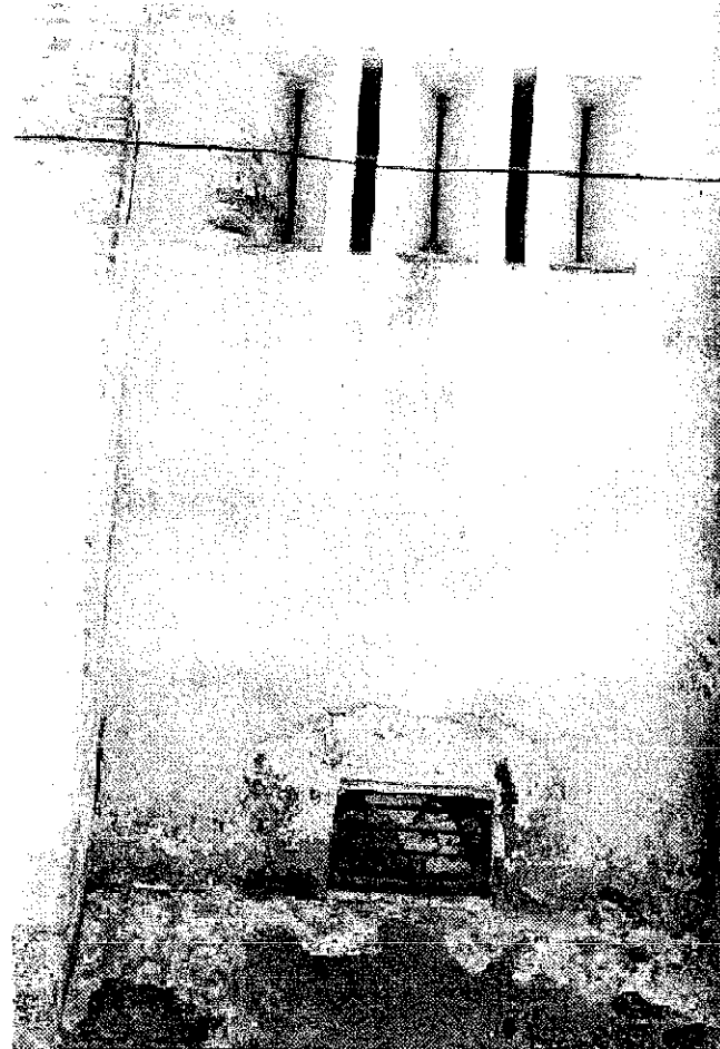
DETALLE DE VENTILACIÓN INFERIOR Y SUPERIOR UNA DE LAS TROJES DE SAN ANTONIO OMETUSCO FOTO DEL AUTOR
