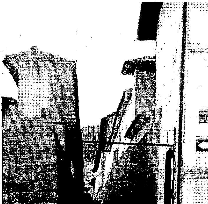
Callejón de Loreto en el cual se observan los vanos tapiados (doble jamba y dintel) Incas, yuxtaposición de muros coloniales. (Fotografía del Autor. 1994)
