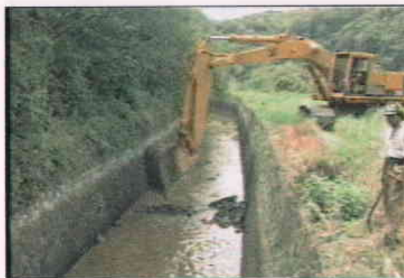
Retroexcavadora extrayendo el azolve recolectado en el interior del canal.
