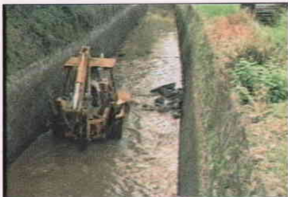
Retroexcavadora amontonando el azolve desde el interior del canal.
