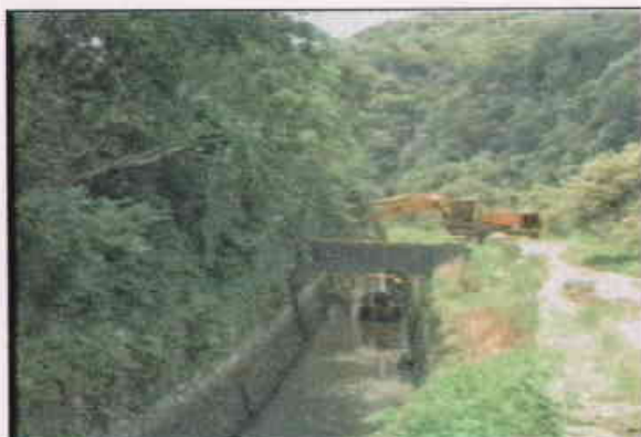
Maquinaria trabajando conjuntamente en las maniobras de limpieza del canal de conducción.
