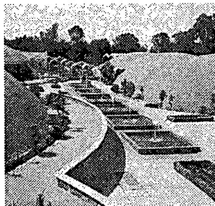
patio del Museo de Historia Natural de la Ciudad de México, 1969. Hoy las deterioradas bóvedas esperan impermeabilización y pintura.
