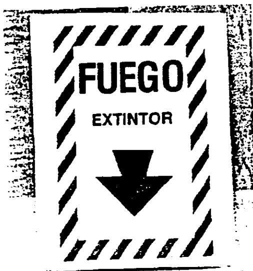
Fig. 19-1D. Identificación de extintor. Debe colocarse de forma que resulte claramente visible desde una cierta distancia (The Badger Company).
