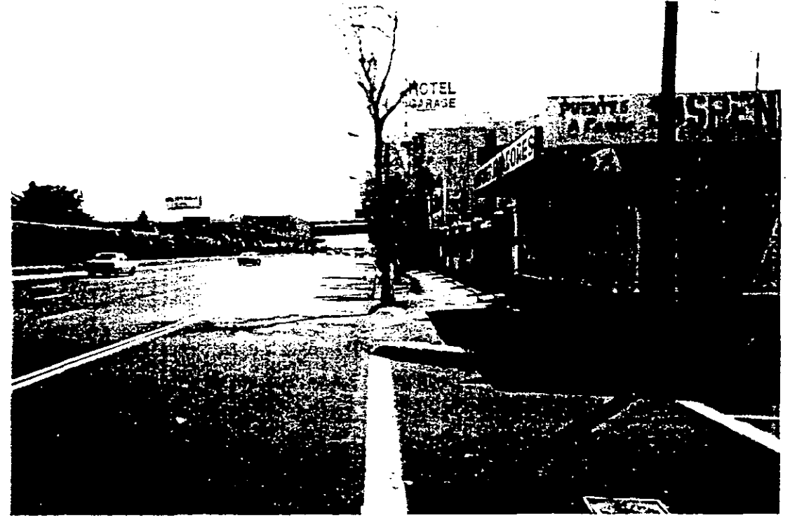
VISTA DE NORTE A SUR SOBRE CALZADA DE TLALPAN
