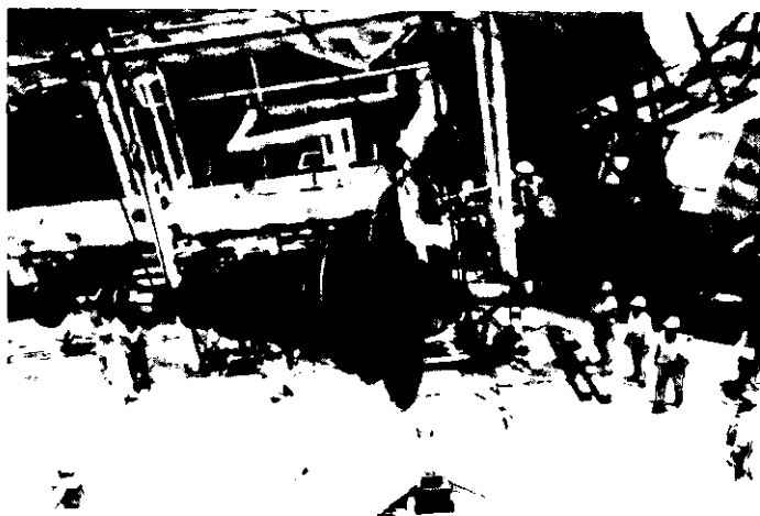
Fig. 5.35 Maniobras que se realizan con el rotor de una turbina de vapor antes de realizar su montaje final
