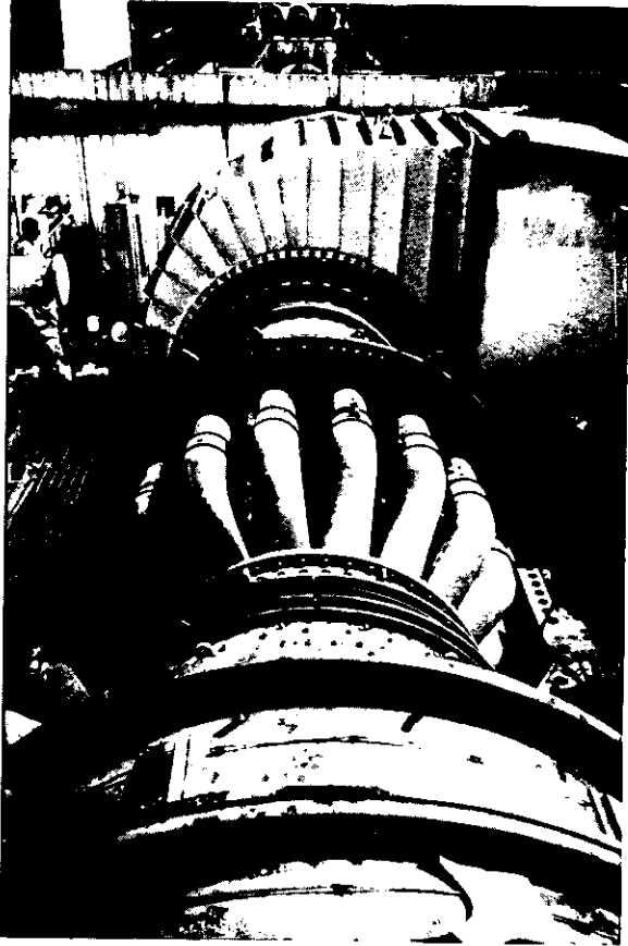
Fig. 5.51 Turbina de gas U-2 en mantenimiento mayor.
