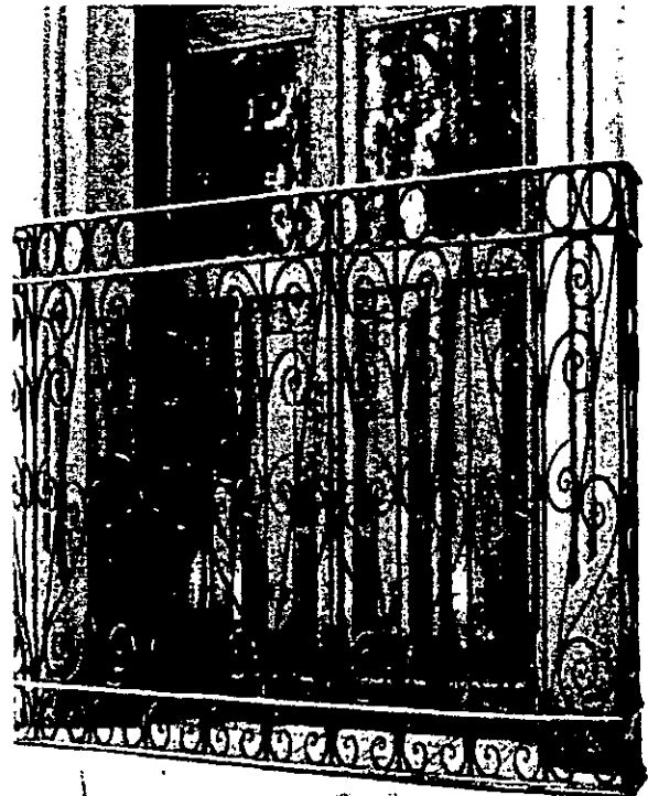
Balcón de Hierro Forjado, Puebla, Pue.
