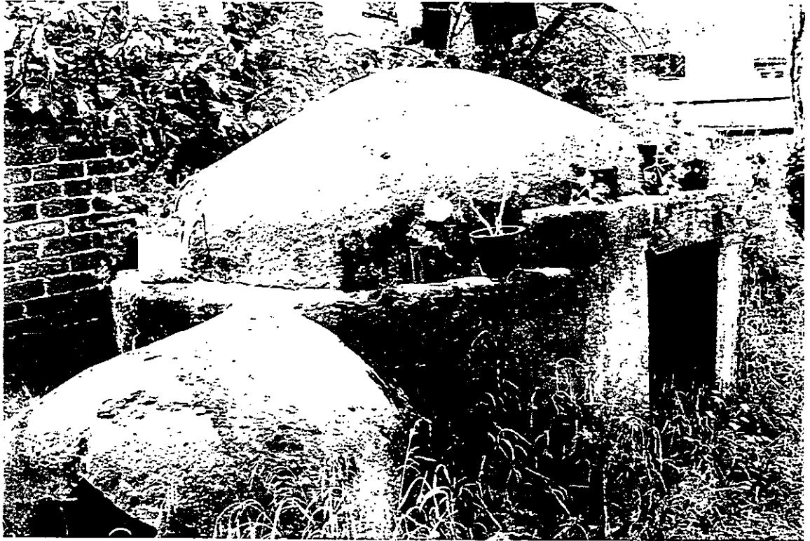
Ilustración núm 38: La hornilla del baño de temazcal, tipo redondo, de piedra, cemento y lodo. Localidad: Santa Ana Tlacotenco, Milpa Alta (D.F.).
