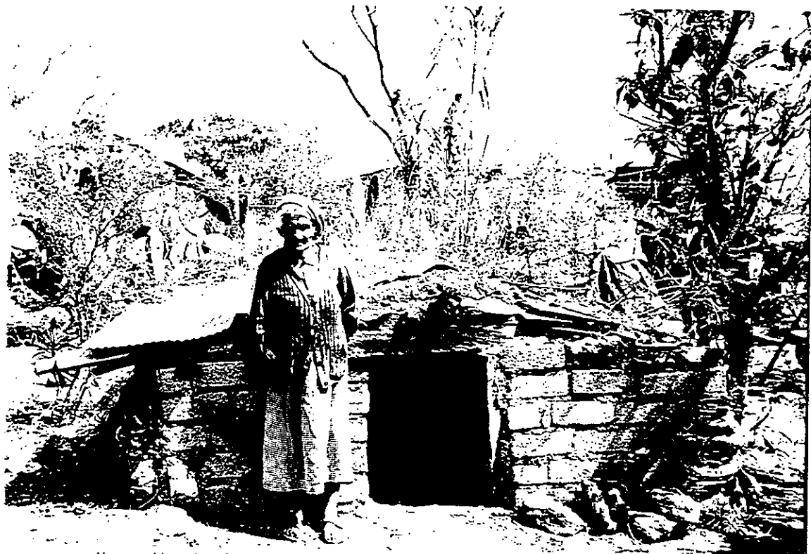
Ilustración núm. 35: Temazcal de tabiques, lodo y cemento, tipo rectangular. Localidad: Yucuñuti de Juárez, Mixteca Baja (Oaxaca).
