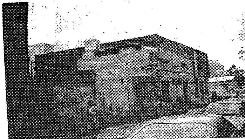
fig. 16 Calle Dos de Abril construcciones en mal estado.
