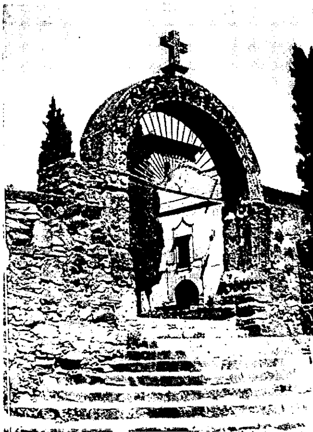
Puerta lateral de la Parroquia única de las 3 que cuenta con escalones
