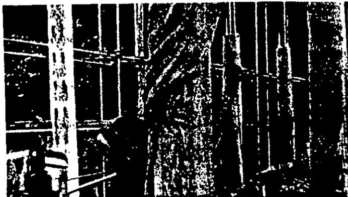
Fig. 15 Curado de unas columnas de concreto, empleando hojas de polietileno y yute mojado
