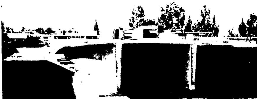
Fig. 17 Trabes TT son elementos estructurales de concreto presfórzado prefabricado.
