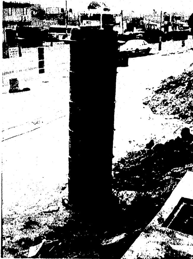
Fig. 23 Cimbra especial para la construcción de columnas
