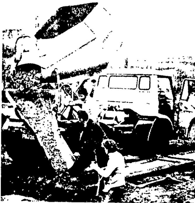
Fig. 13 Transportador montado en un camión capacidad 2-3m<sup>3</sup> descargando en una fosa para cimentación
