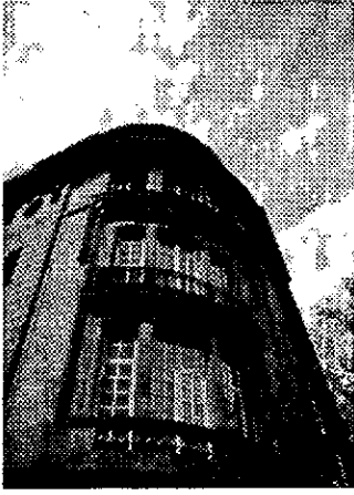
Edificio del Centro Joyero
