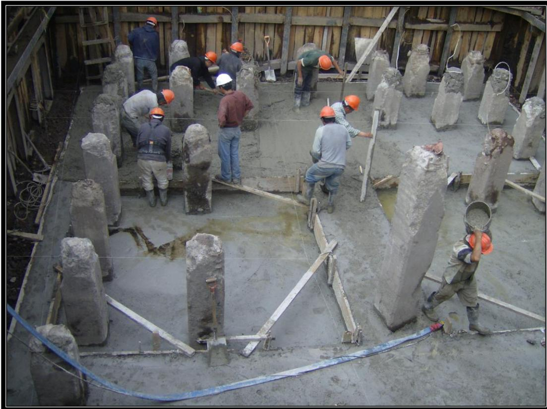
*Figura IV.6.1.- Colocación de plantilla de concreto pobre.*
