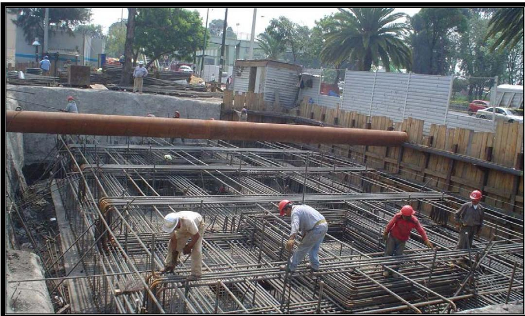
*Figura IV.7.1.3b.- Trabajos de colocado de acero para contratrabes.*
