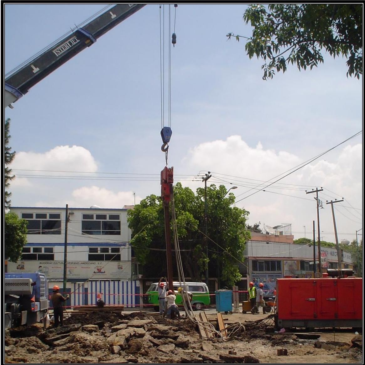
*Figura IV.5.1.2.- Hincado de vigüeta IPR ligera a base de un equipo vibrohincador, (Calzada Acoxpa).*
