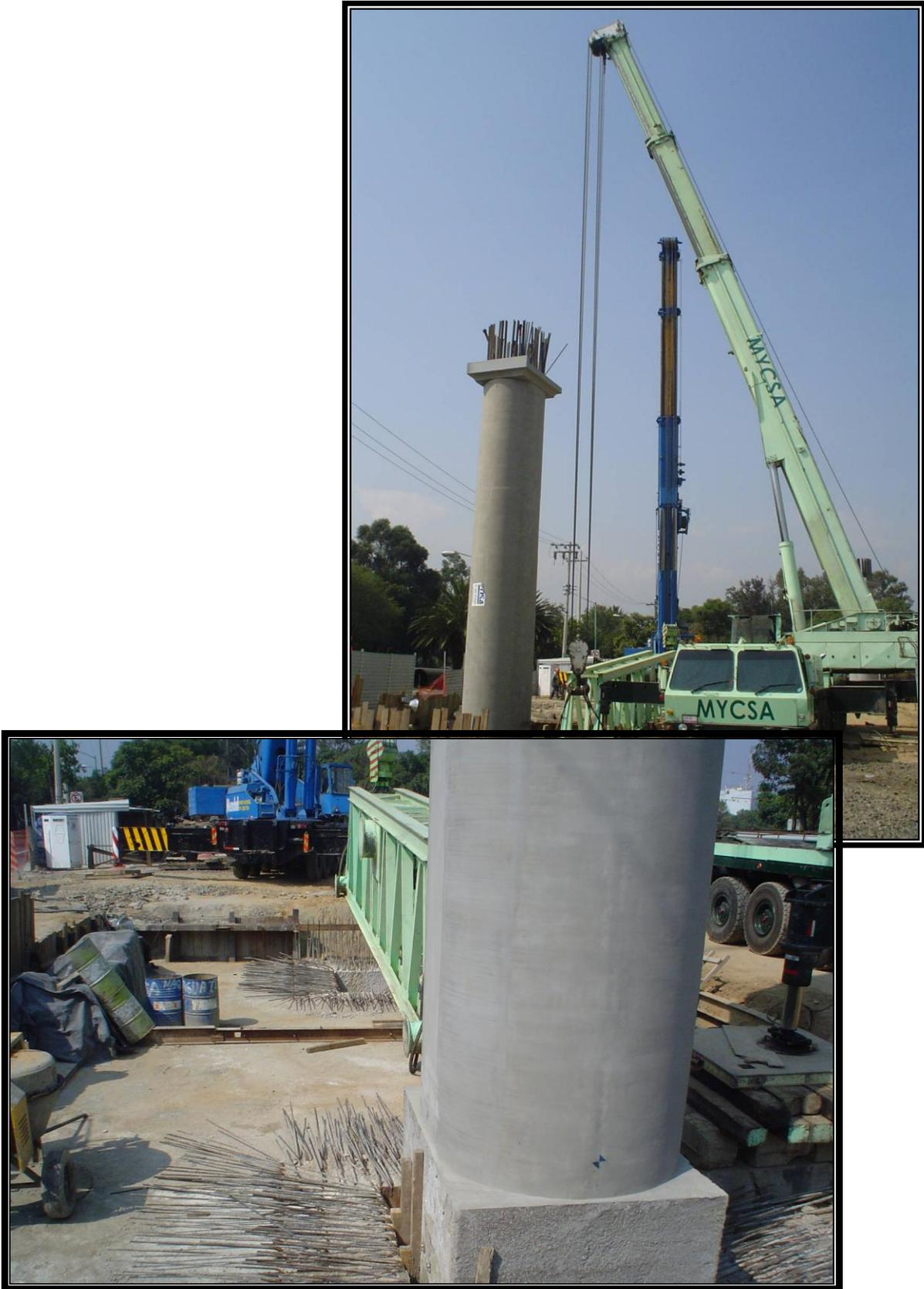
*Figura IV.8.4.2.- Izado y colocación de la columna A10.*
