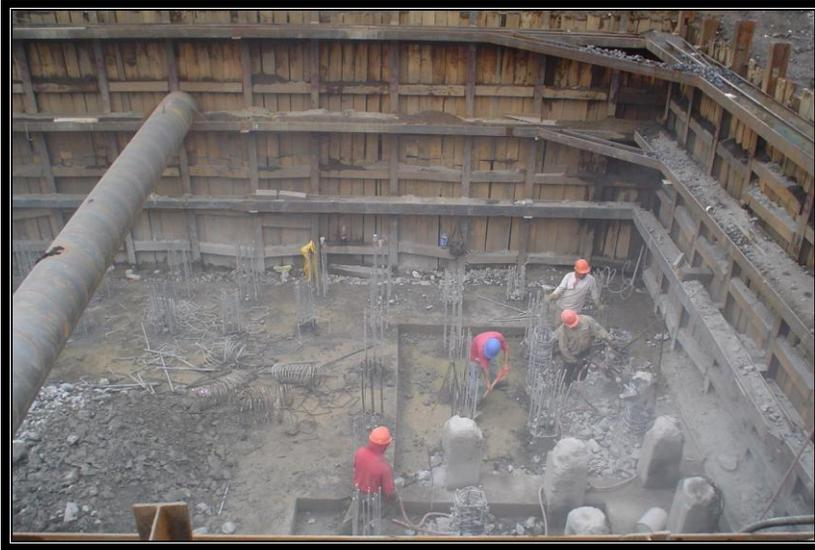
Figura IV.6.2a.- Proceso de descabece de pilotes
