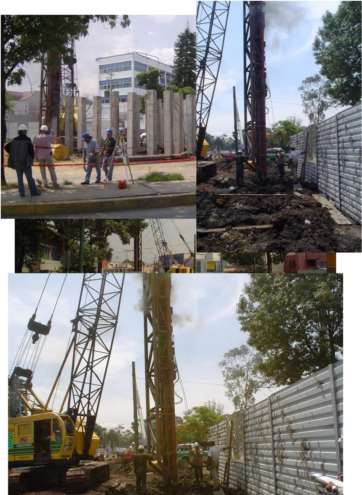
*Figura V.4.2.5b.- Proceso de hincado de pilotes en el frente de trabajo Norte (Calzada Acoxpa)*
