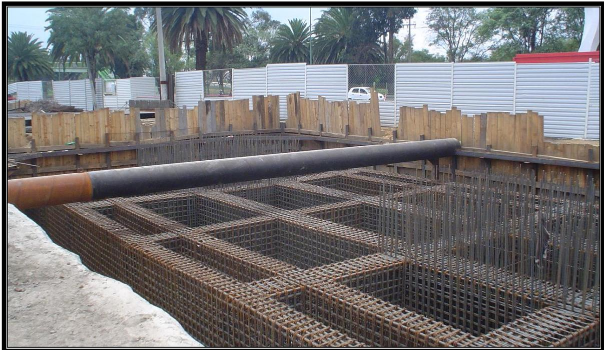
*Figura IV.7.2.6.- Armado terminado de zapata A10 – A11.*
