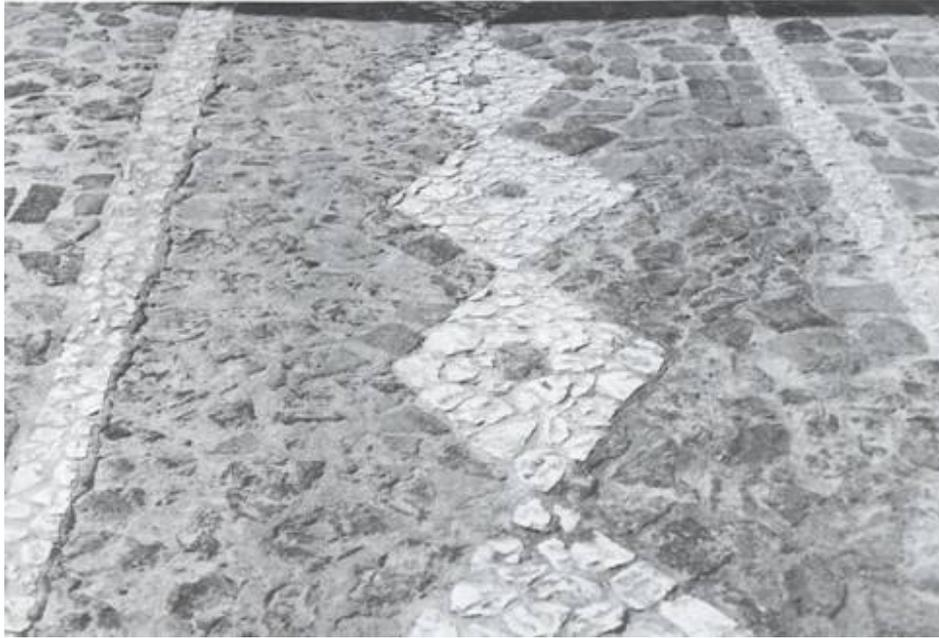
Figura. 27.- Pavimento de lajas de piedra, utilizando dos colores. La combinación le imprime un carácter muy atractivo.<sup>28</sup>
