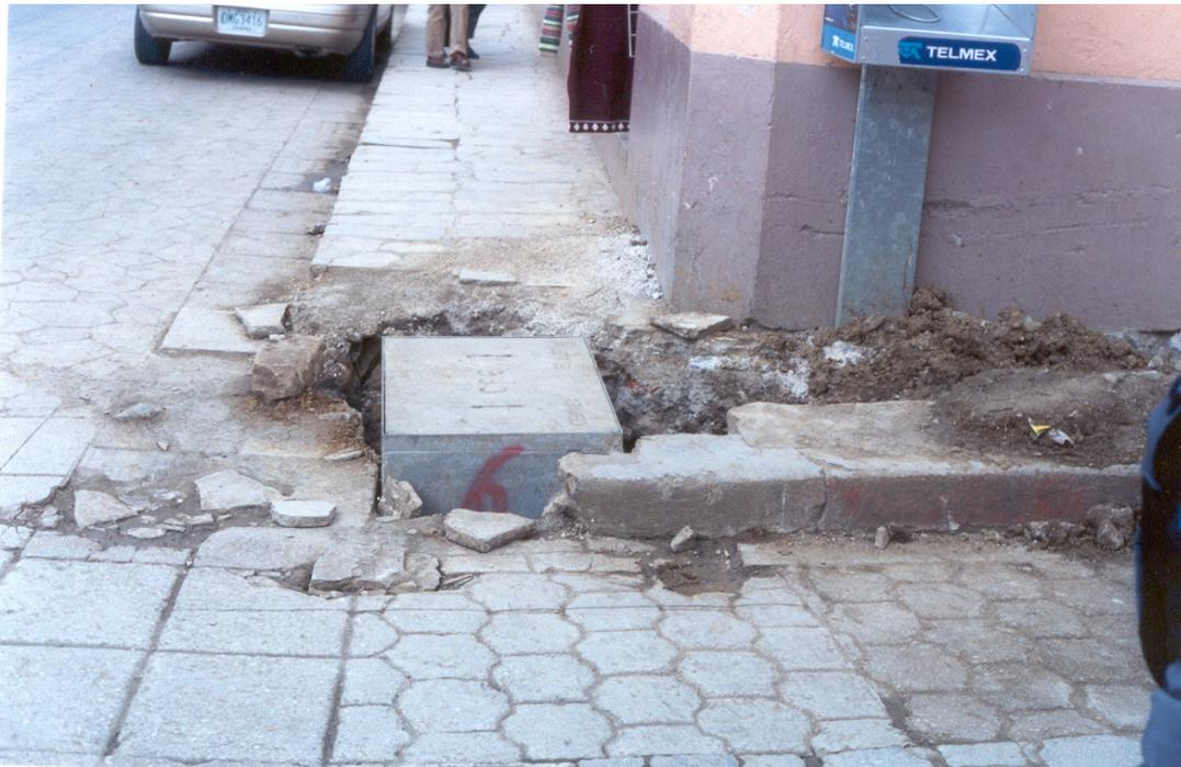
Figura. 46.- Detalle de un transformador subterráneo en proceso de obra.
