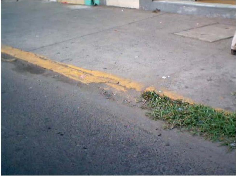
Figura. 110.- Banquetas con guarnición de baja altura.
