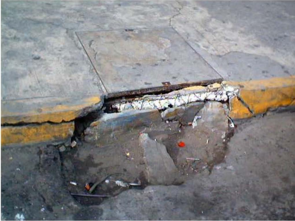
Figura. 114.- Detalle de registro con desprendimiento y pérdida de material de guarnición y registro.
