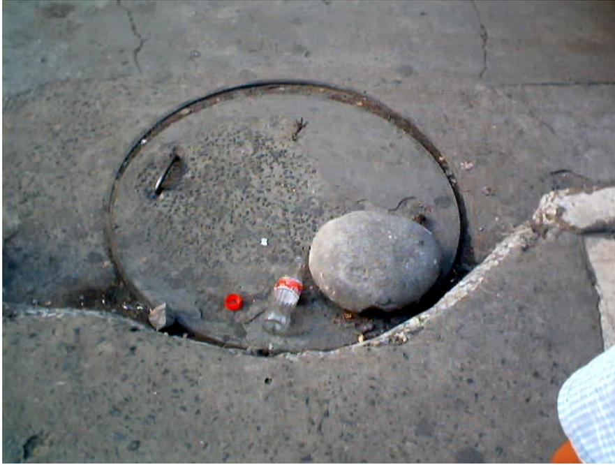
Figura. 102.- Esta foto muestra que las tapas de pozos de registro están sin guarnición y sin banquetta completa.
