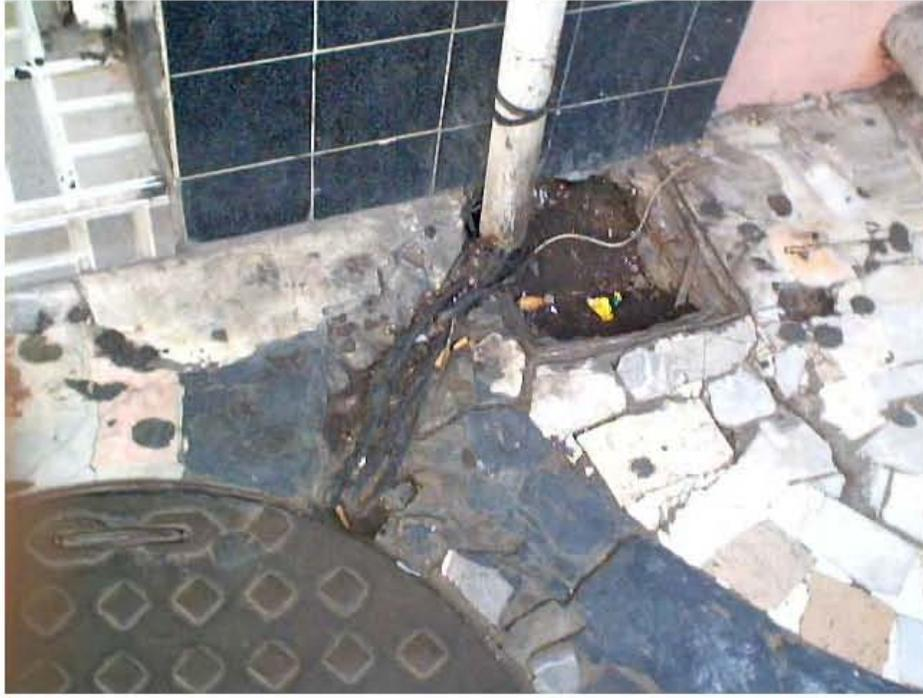
Figura. 97.-Cables sueltos.
