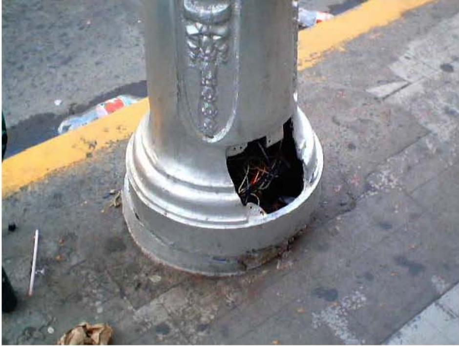
Figura. 98.- Detalle de poste con cables expuesto a la intemperie.
