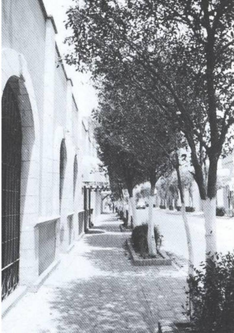
Figura.26.- Acera y vialidad de adocreto (adoquín artificial) con color integral.<sup>27</sup>
