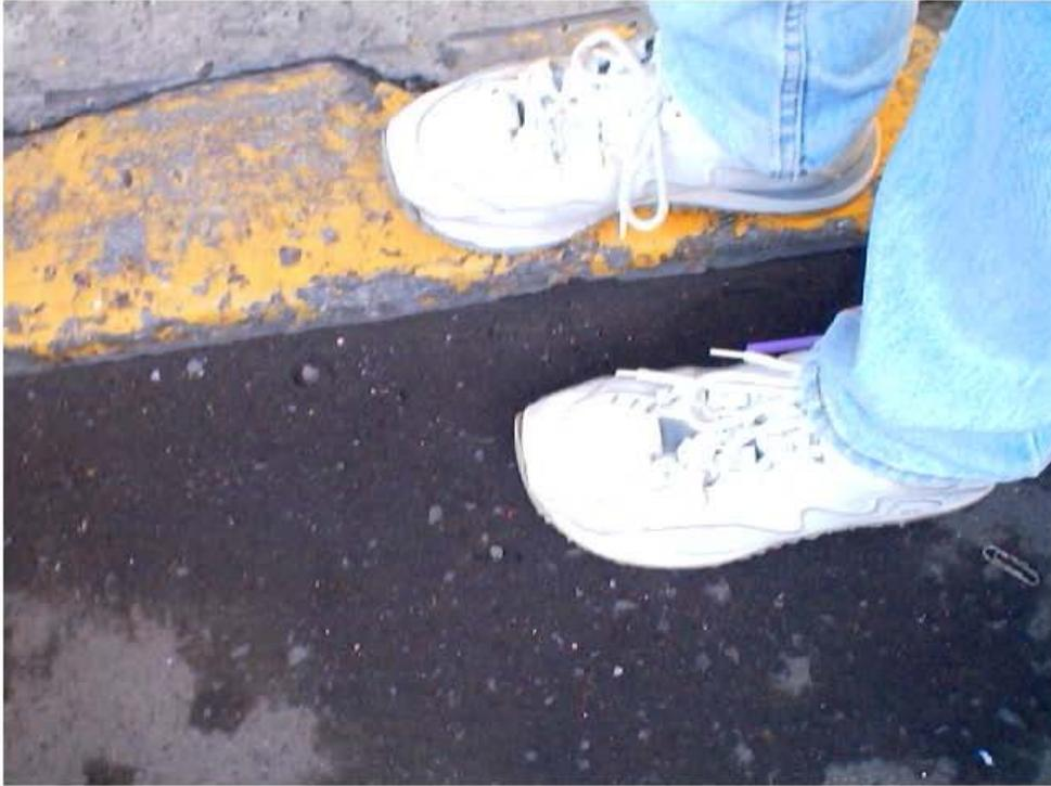
Figura. 113.- Como muestra mas clara, en esta foto podemos observar que las banquetas casi han perdido su guarnición.
