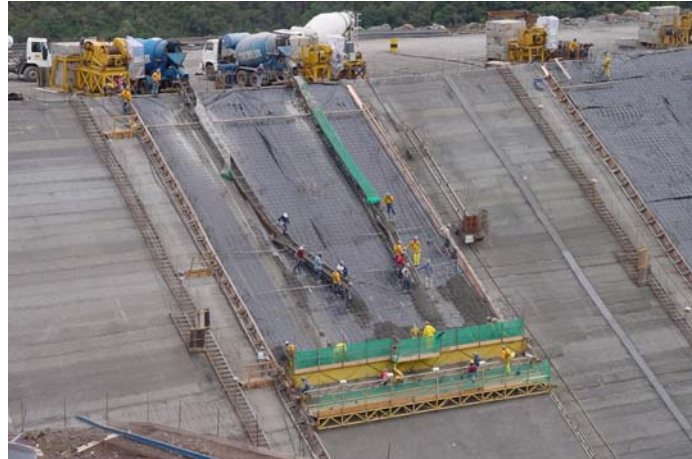
Fig. III. 3. Cimbra deslizante para el colado de las losas de concreto.
