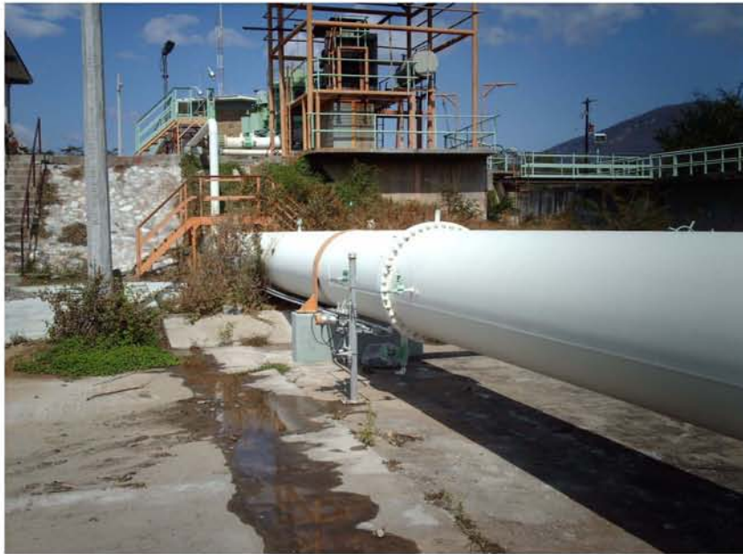
Figura 2.8. Acueducto de la salida de bocatoma Las Pilas Refinería.
