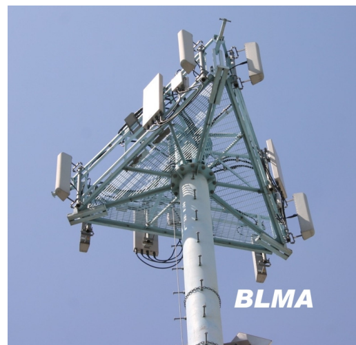
Figura I.21. Arreglo de dipolos para una BTS.
