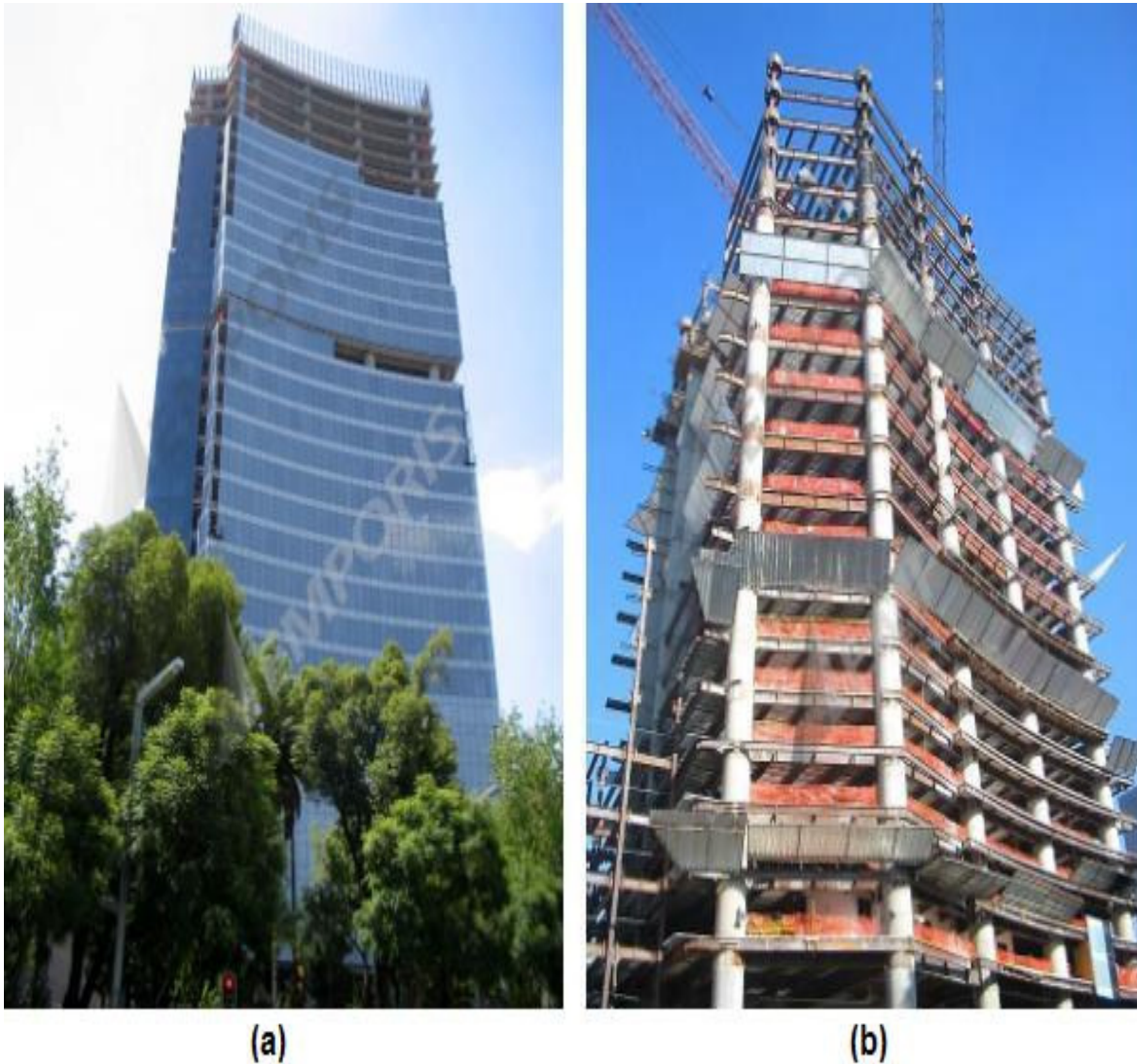
Figura IV.3. Fachada y estructura principal del inmueble.
