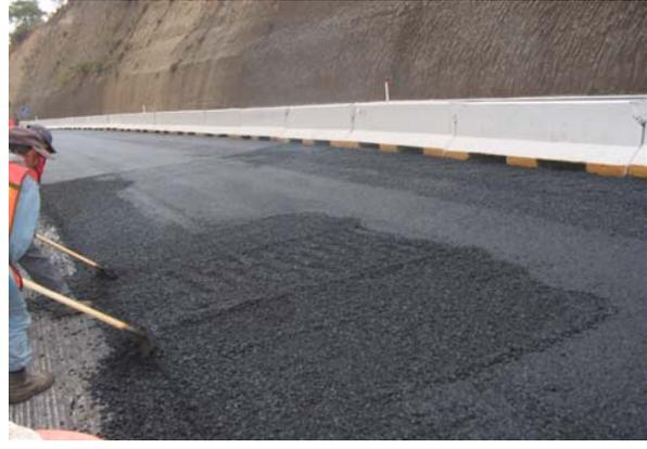
Rastrilléo del concreto asfáltico tendido de la base negra
