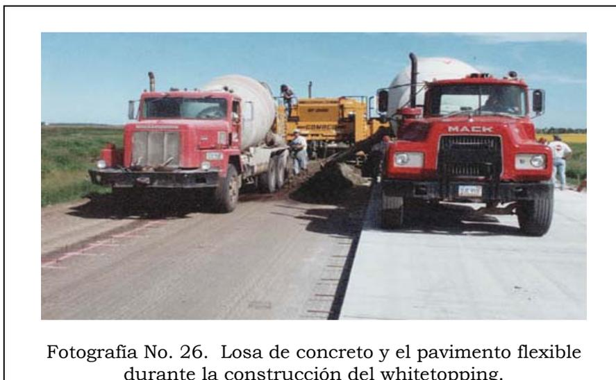
Fotografía No. 26. Losa de concreto y el pavimento flexible durante la construcción del whitetopping.
