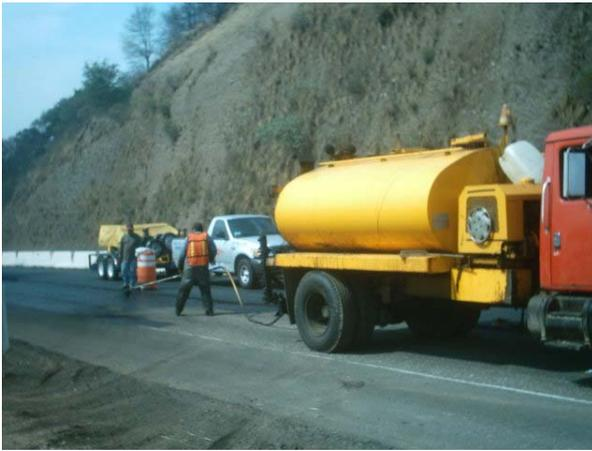
Riego de Impregnación sobre la superficie fresada
