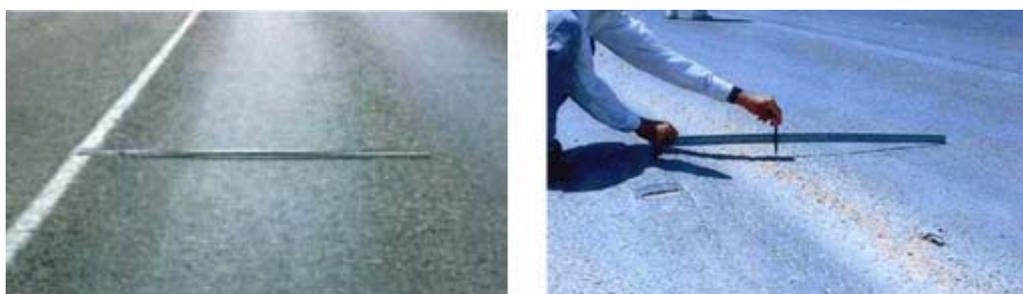
Fotografía No. 22. Roderas, deformación típica de pavimentos flexibles. Fuente: **REF\*18**
