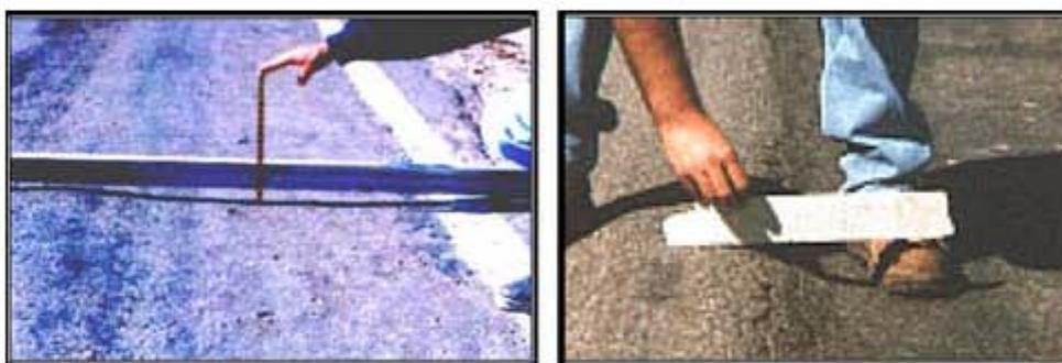
Fotografía No. 23. Deformaciones plásticas de carácter permanente en pavimentos flexibles. Fuente: **REF\*18**
