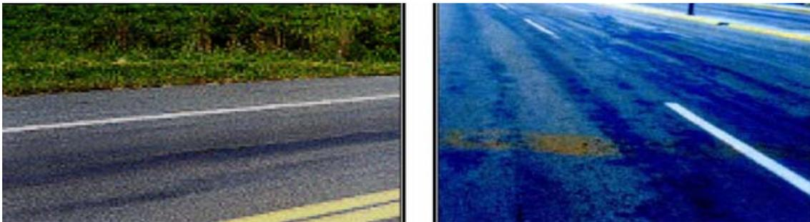
Fotografía No. 19. Exudaciones en pavimentos asfálticos. **REF\*15.**
