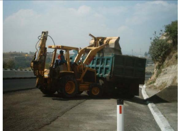
Carga de material de fresado
