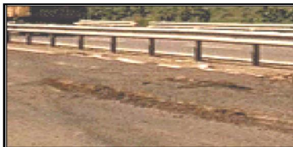
Fotografía 19. Desenvuelta de los agregados que deriva en desgrane de la capa de rodamiento. **REF\*15**
