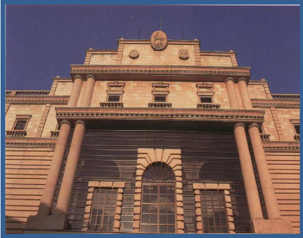
Figura 4 Fachada posterior de la biblioteca 20
