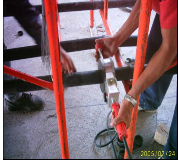
En estas fotos se observa la preparación de tubería para red exterior de agua potable exterior. En la foto de la derecha se observa la termofusión entre 2 tramos de tubería, de 6 metros cada uno.
