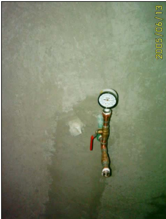
En la foto de la izquierda se observa la realización de prueba de hermeticidad a una parte de la red interna de agua potable. En la foto de la derecha se muestra la aplicación de la prueba de hermeticidad a una parte de la red de protección contra incendios que se encuentra instalada en la techumbre del Centro Comercial.
