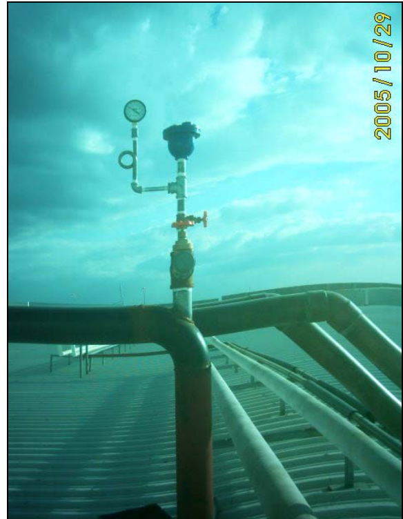
En la foto de la izquierda se observa la realización de prueba de hermeticidad a una parte de la red interna de agua potable. En la foto de la derecha se muestra la aplicación de la prueba de hermeticidad a una parte de la red de protección contra incendios que se encuentra instalada en la techumbre del Centro Comercial.
