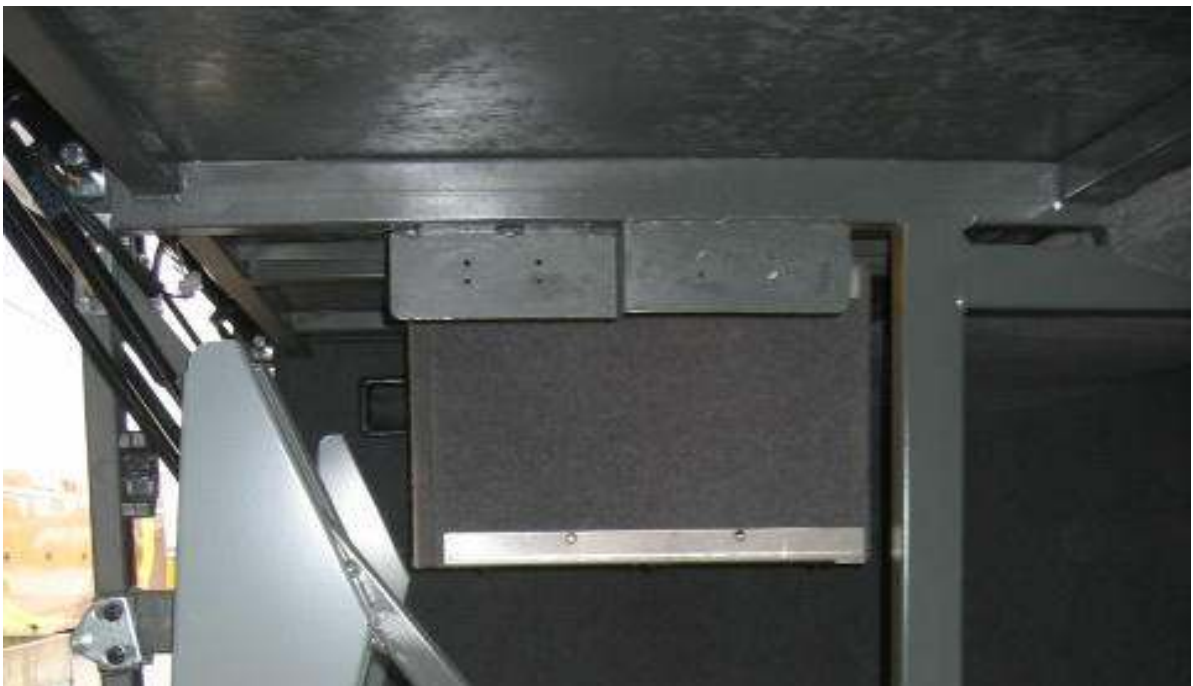
Foto 9. Modificación de rejilla en puerta de servicio para escape.
