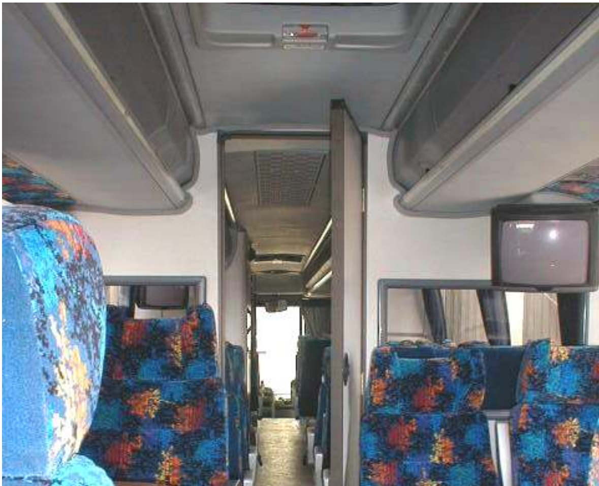
Foto 4. Instalación de un baño central a un costado de la segunda puerta de acceso.
