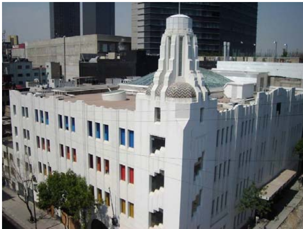
Vista del edificio, esquina de Revillagigedo e Independencia
