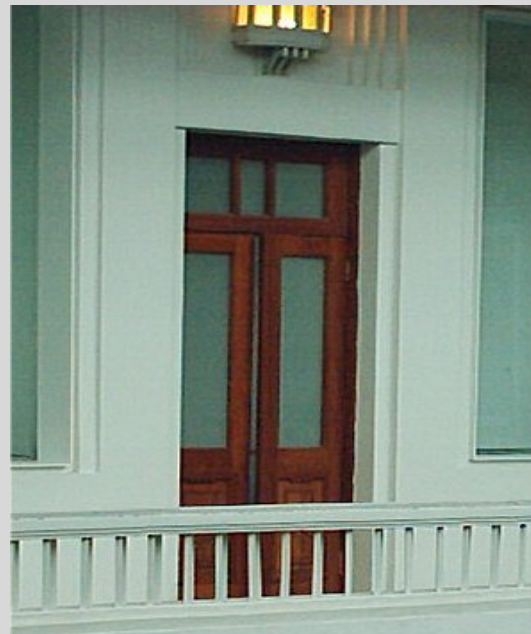
Restauración de las puertas originales
