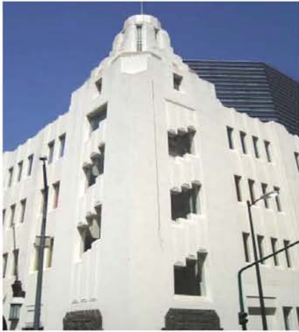
Vista de la torre
