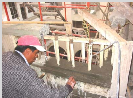
Restauración del barandal original
