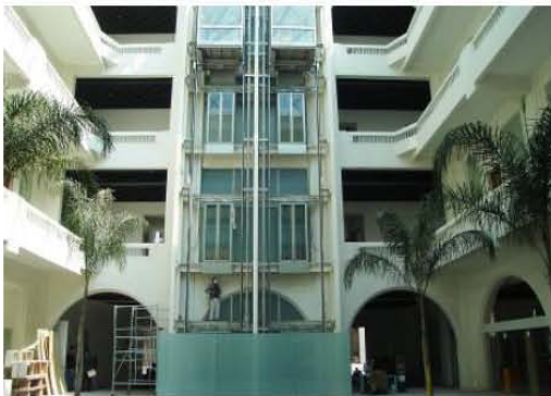
Elevadores panorámicos, Patio Central
