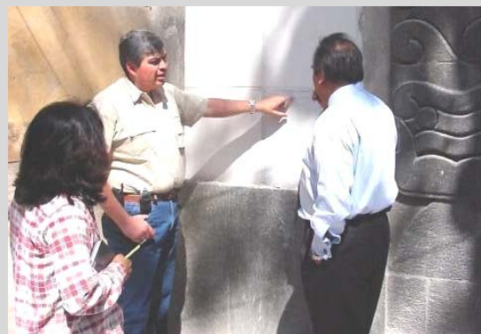
Proceso de aplicación de la pasta en muros exteriores
