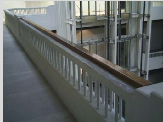
Construcción de la propuesta definitiva para barandal
