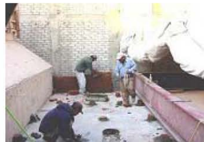
Impermeabilización del área circundante al domo
