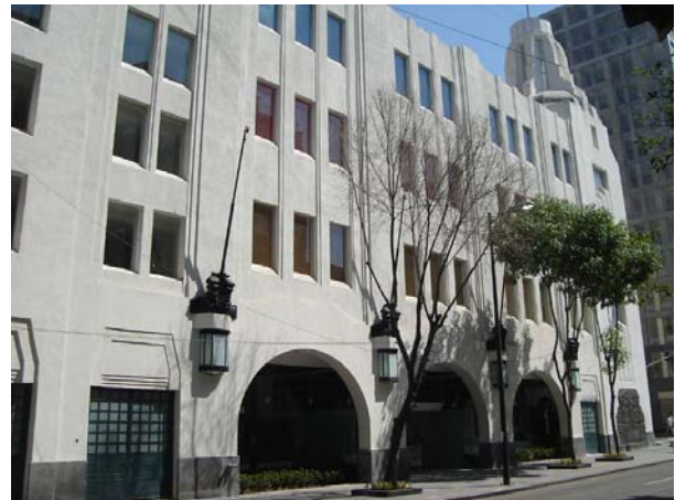
Vista de la fachada calle de Revillagigedo
