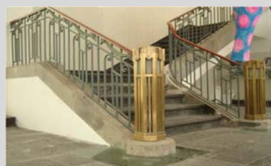
Proceso de restauración de la escalera principal
