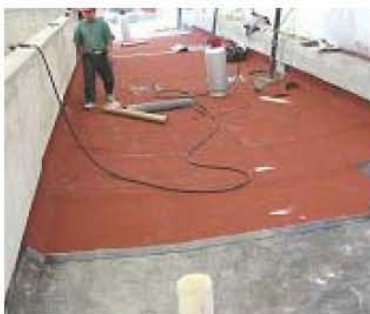
Impermeabilización del área exterior del domo
