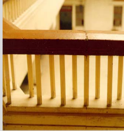
Detalle de barandal original
