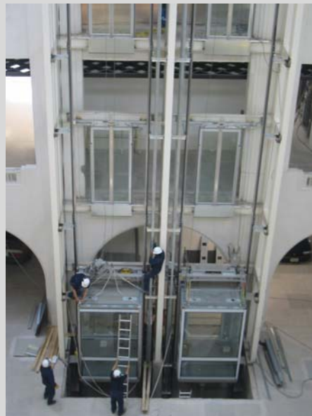
Instalación de cabinas de elevadores
