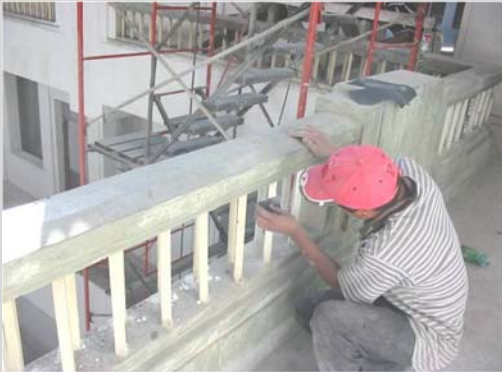
Restauración del barandal original
