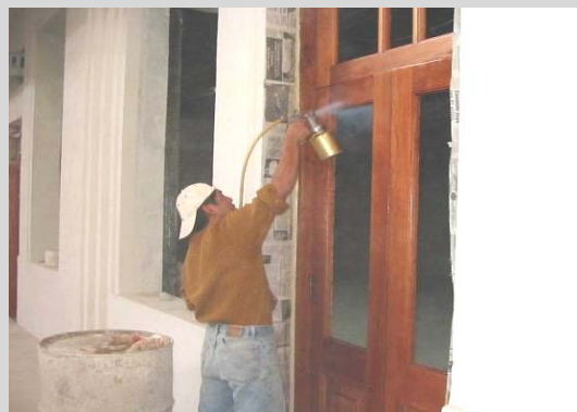
Proceso de restauración de las puertas originales
