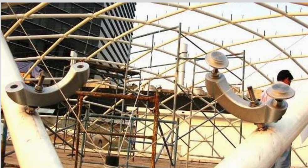
Fijación de las manetas a la estructura
