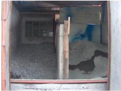
Fig.03 Almacén temporal de agregados
