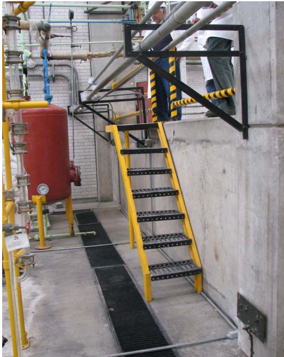
Foto 11: Escalera de acceso a la parte baja de Planta Piloto.
