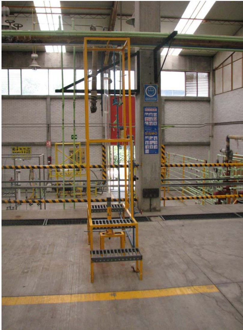
Foto 3: Torre de burbujeo
