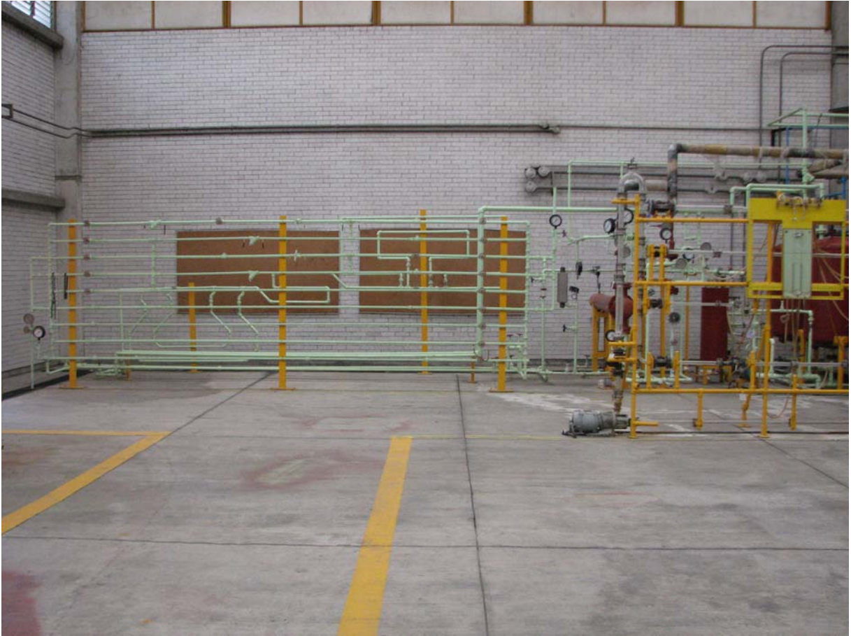
Foto 12: Pisos de la Planta Piloto.
