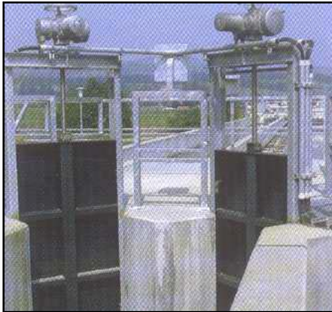
Figura 2. Compuertas tipo guillotina de desplazamiento vertical
