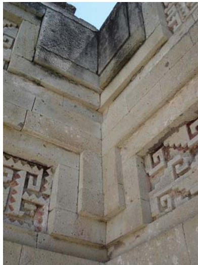
Fig. 16 En esta toma fotográfica se observa el remate en esquina y los cortes, que están perfectamente delineados y acomodados
