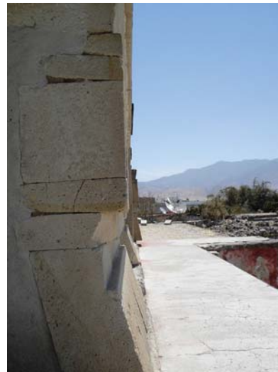
Fig. 17 Este perfil pertenece al edificio de las columnas, nótese la precisión de los cortes en la cantera, y las piezas dispuestas, para levantar el muro.
