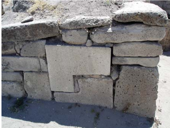
Fig. 15 Este elemento se encuentra en la base donde la pesada estructura se desplantaba, generalmente donde la estructura hacía esquina en sus lados
