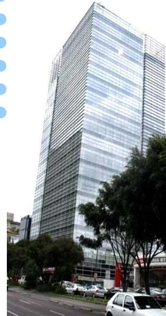
Las fachadas están fabricadas con cristal de tipo tintex, en color azul, este se sostiene en un reticula hecha a base de marcos de aluminio fijados a la estructura principal del edificio.
