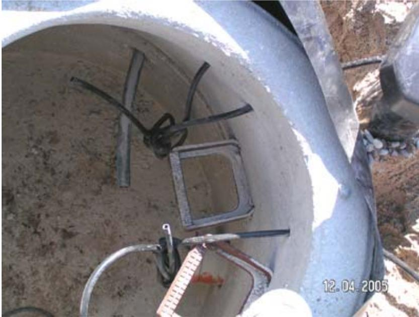
**Fig. 4.19:** Pozo de control, nótese las mangueras del sistema de irrigación y el efluente que viene del filtro (foto propia)
