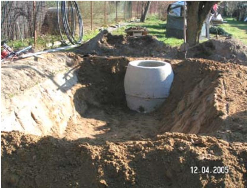
**Fig. 4.10:** Excavación de la zanja para el filtro, nótese el pozo de control colocado en el punto más bajo de la excavación a un extremo. (Foto propia)
