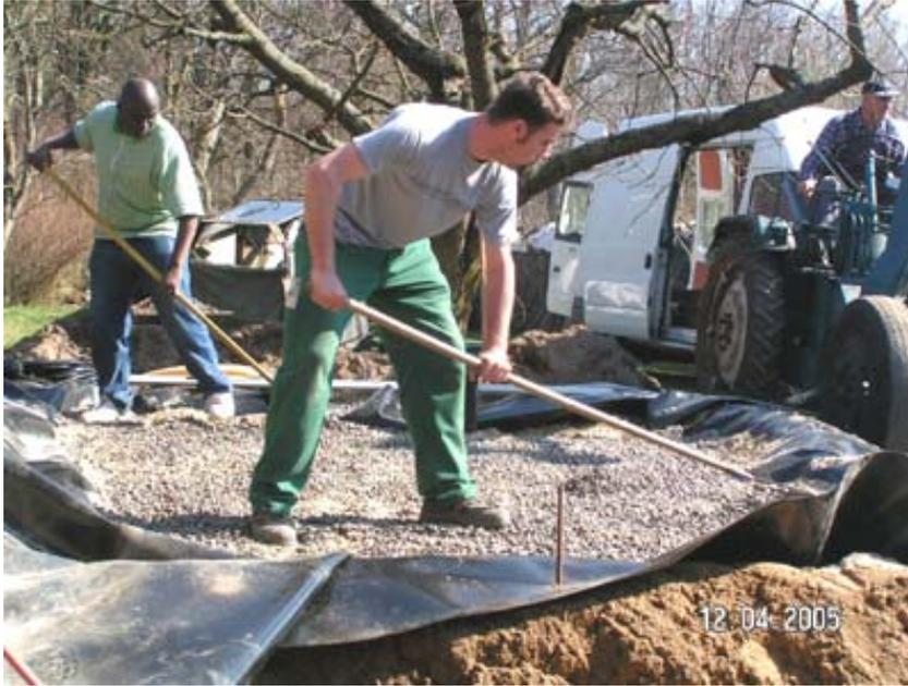
**Fig. 4.14:** Tendido y nivelación a mano de la cama superior de grava. (Foto propia)
