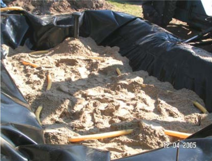
**Fig. 4.12:** Colocación del sistema intermedio de aireación pasiva, nótese al fondo de la imagen la torreta de inspección, que es a su vez, la toma de aire. (Foto propia)
