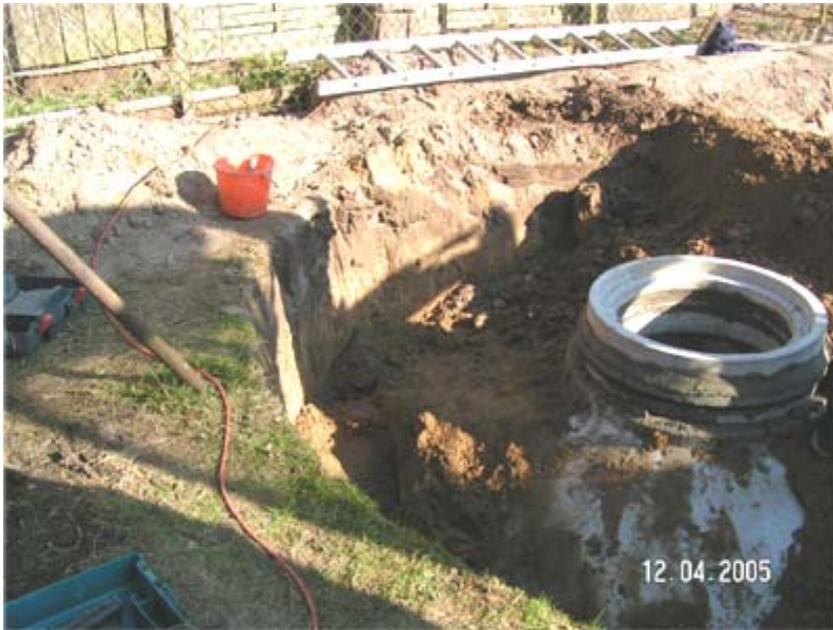
**Fig. 4.4:** Tanque prefabricado de concreto para sedimentación en tres etapas. (Foto propia)
