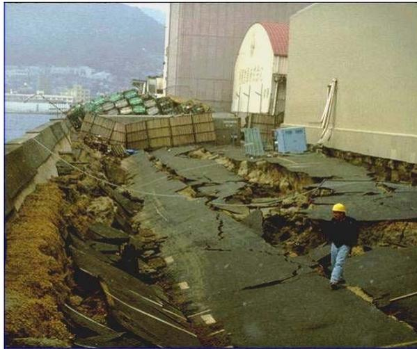
**Figura 1.8 Inestabilidad de muros de contención**
