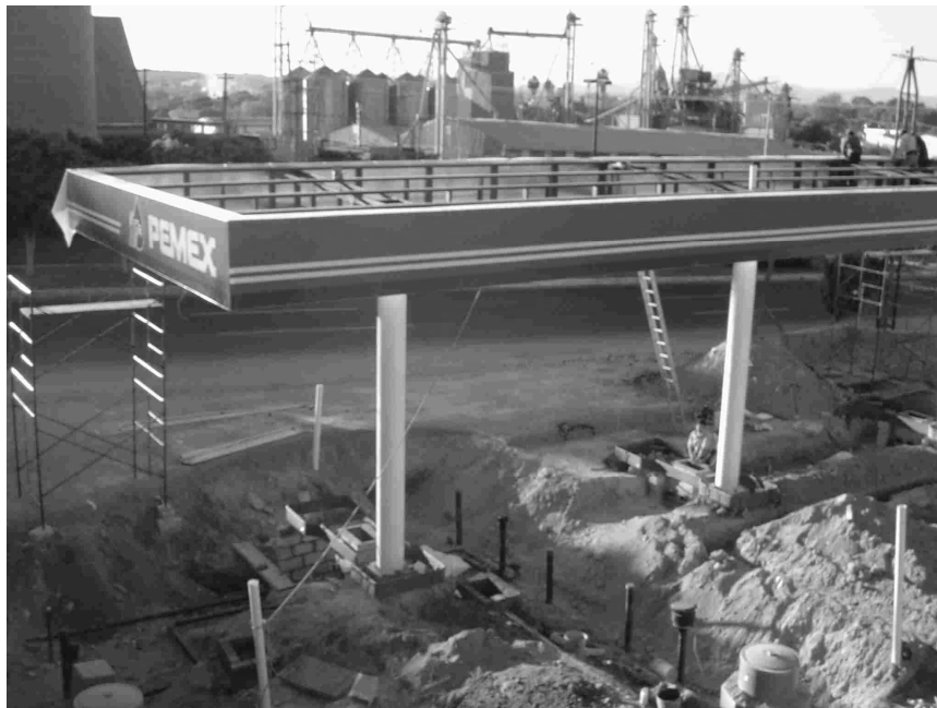
Figura 4.1.7 Detalle de colocación de faldón metálico institucional
