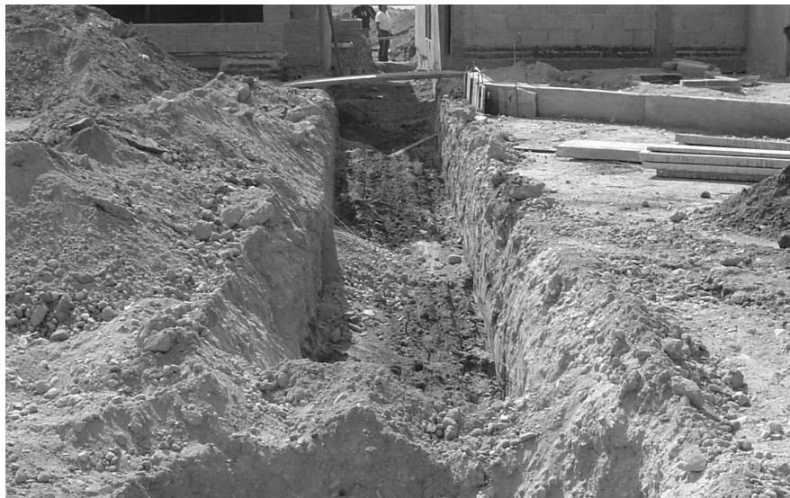
Figura 8.2.2 Excavación de cepas en terreno mejorado
