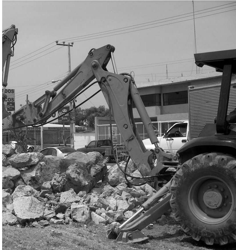
Figura 3.1.1 Demolición de estructuras existentes
