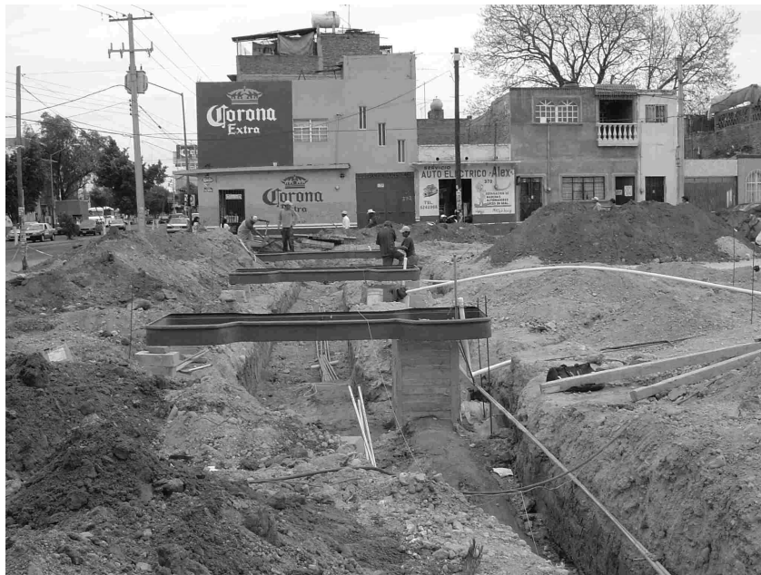
Figura 4.1.4 Detalle de cimbra metálica (hueso de perro)
