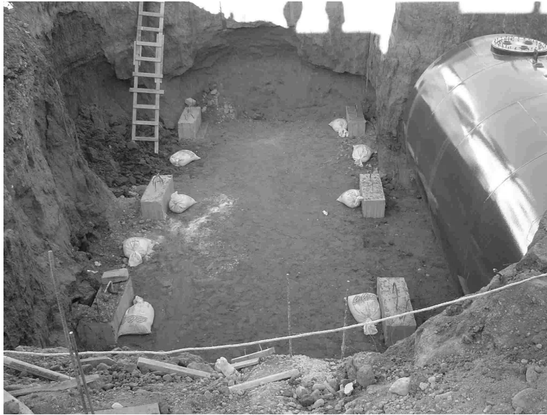
Figura 4.2.2 Detalle de plantilla y anclaje del tanque
