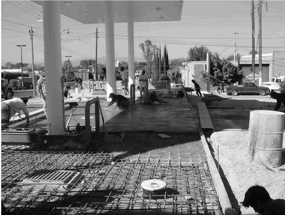
Figura 4.1.9 Detalle de armado y colado de losa
