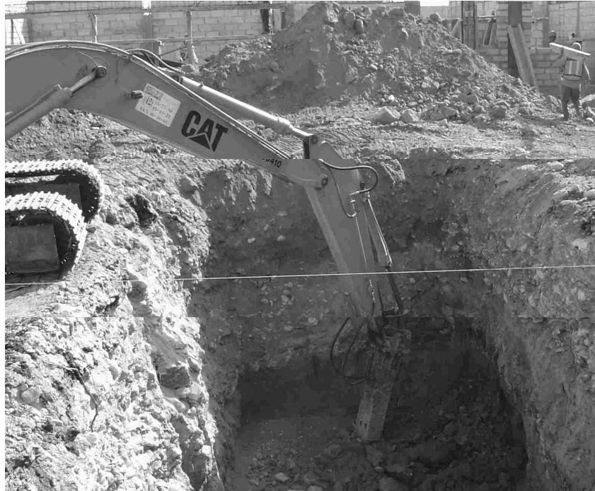
Figura 3.4.1 Excavación por medios mecánicos en materiales tipo II y III
