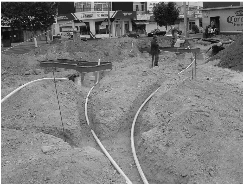
Figura 4.1.2 Instalación de tuberías
