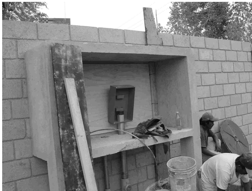
Figura 4.3.1 Detalle de construcción de nicho para recibir acometida eléctrica
