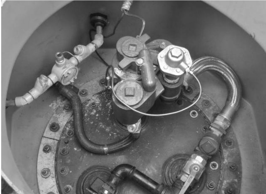
Figura 7.7.2 Bomba sumergible y conexiones
