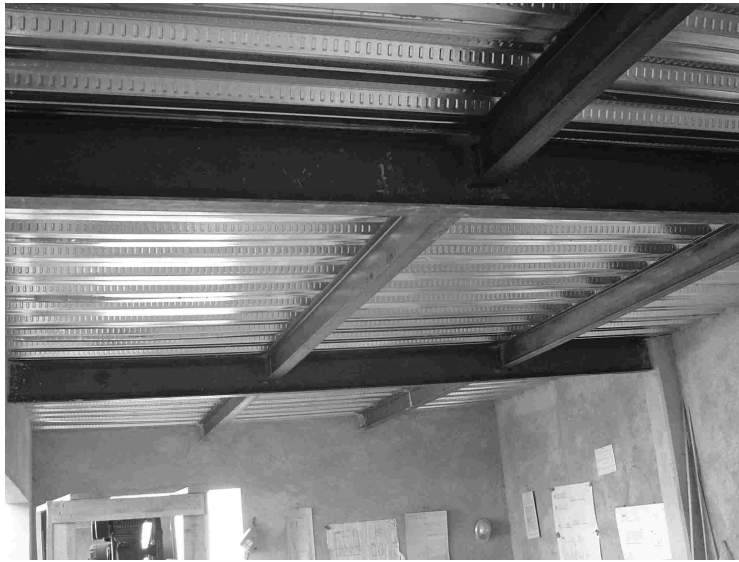
Figura 5.4.3 Colocación de losacero soldado a las vigas metálicas IPR de 10"
