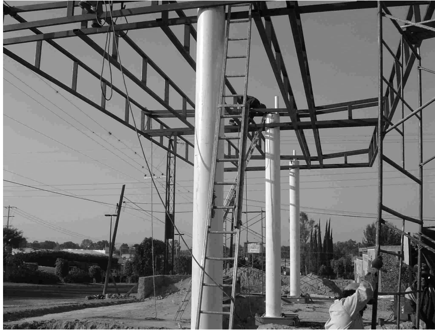
Figura 4.1.6 Detalle de estructura soporte de techumbre
