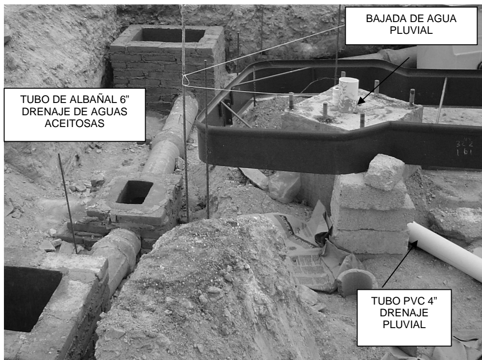
Figura 8.3.1 Drenajes pluviales y de aguas aceitosas
