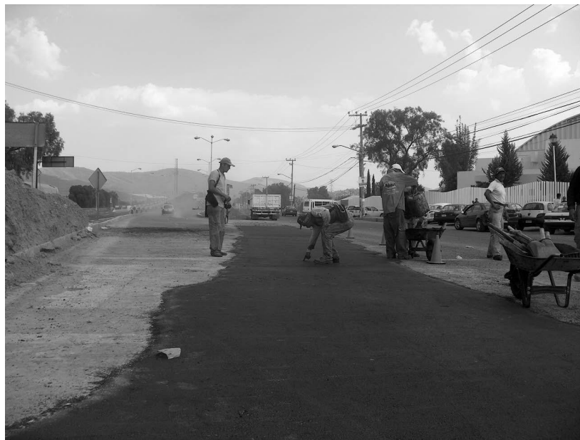
Figura 3.5.1 Aplicación de concreto asfáltico
