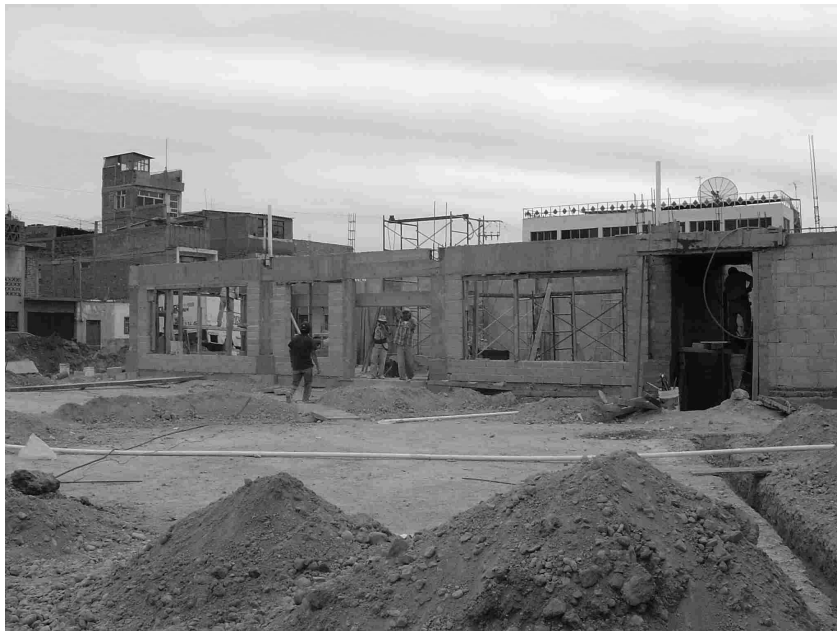
Figura 5.4.1 Construcción de muros de tabique
