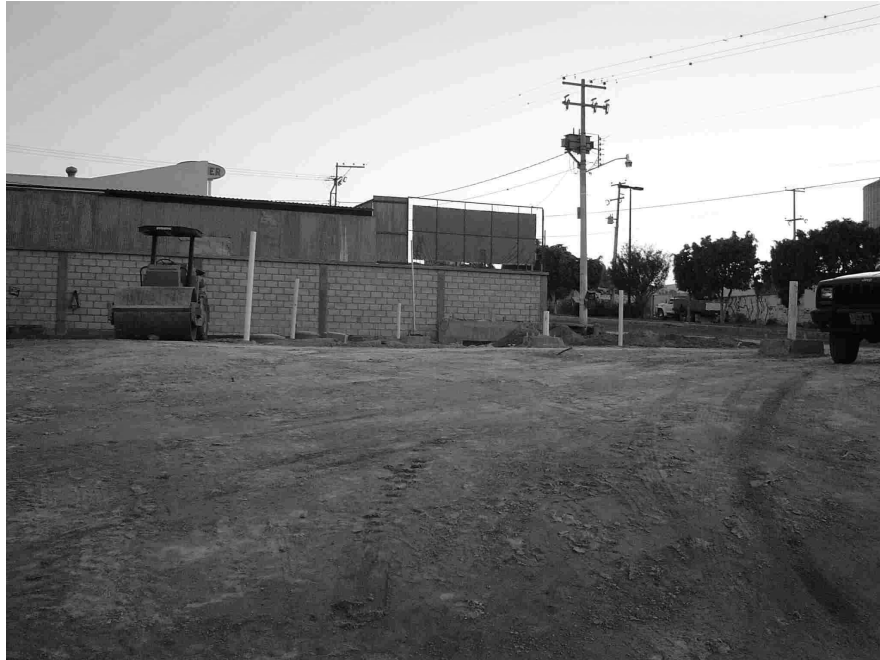
Figura 3.3.1 Trabajos de terracerías
