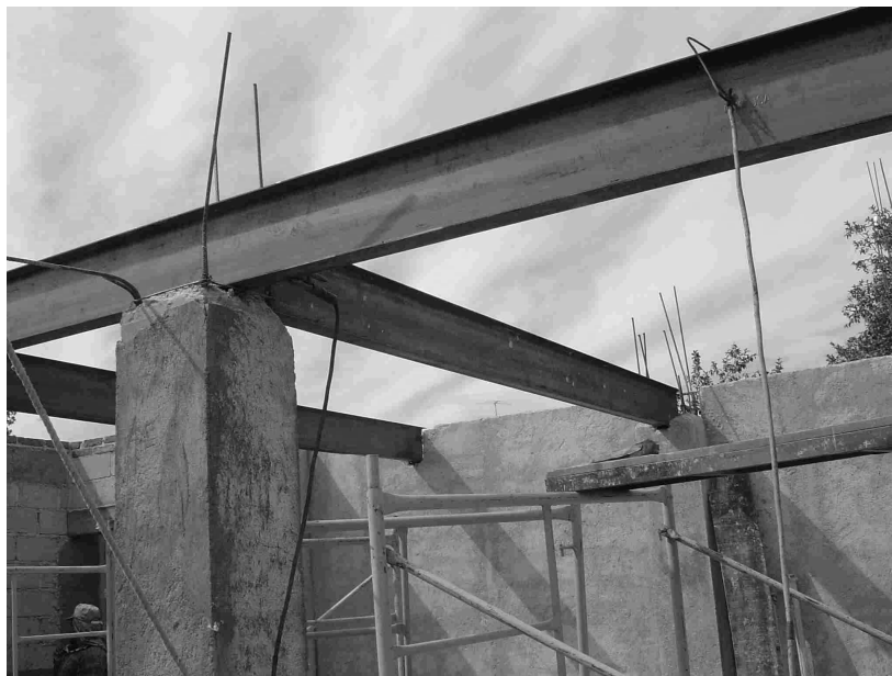
Figura 5.4.2 Colocación de vigas metálicas IPR de 10"
