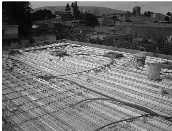
Figura 5.4.4 Colocación de malla electrosoldada 6-6, 10-10 y poliducto para instalaciones eléctricas
