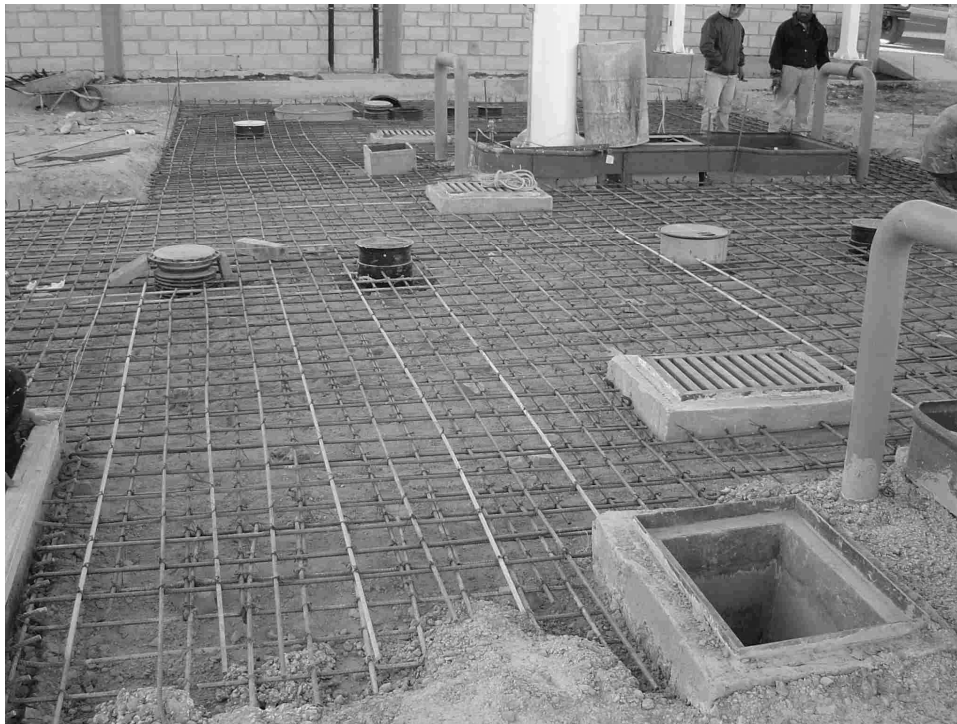
Figura 4.1.8 Detalle de armado de losa
