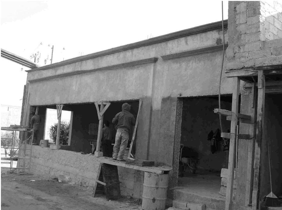
Figura 5.7.1 Detalle de aplanados en muros y plafones
