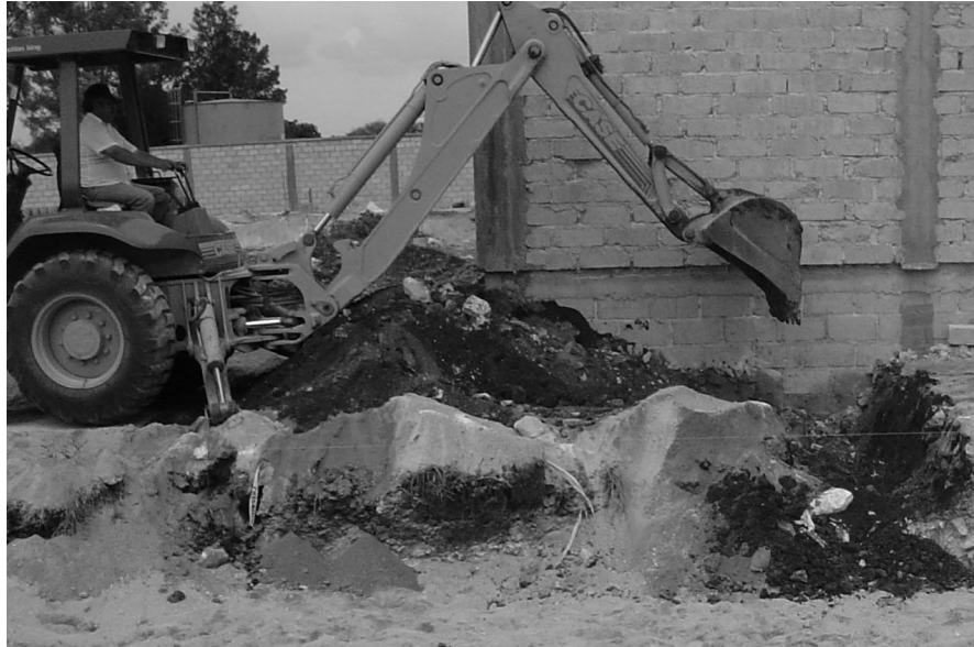
Figura 8.2.1 Excavación de cepas con máquina
