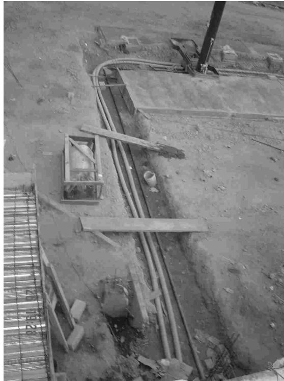
Figura 4.4.1 Trinchera para colocación de ductos
