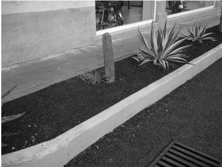
Figura 5.9.2 Detalle de guarnición terminada
