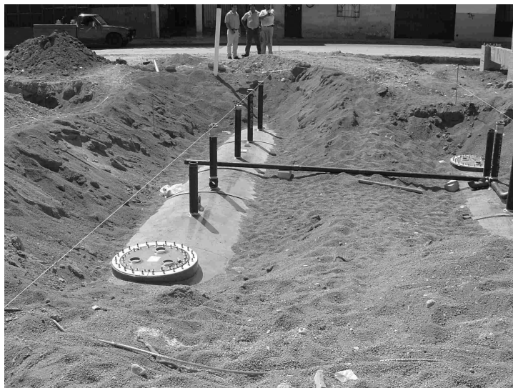
Figura 4.2.3 Detalle de relleno con arena y grava de fosa de tanques
