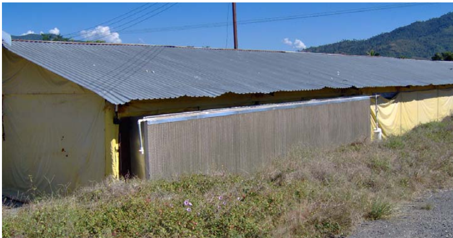
Foto 35. Nave de ambiente controlado.
