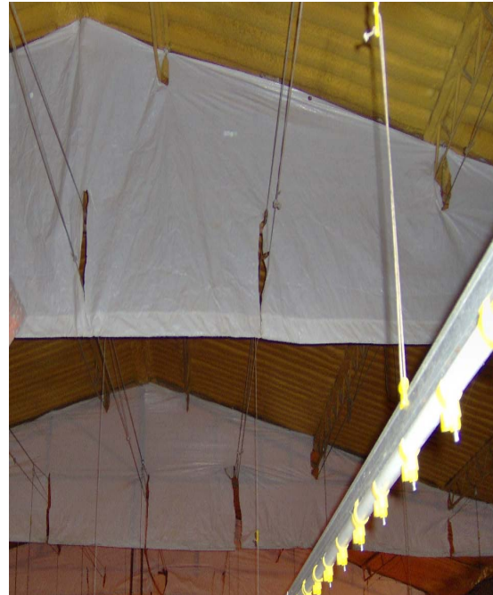
FOTO 39. Techo cubierto con poliuretano.
