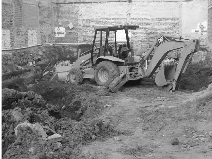
La excavación se realizó por medios mecánicos
