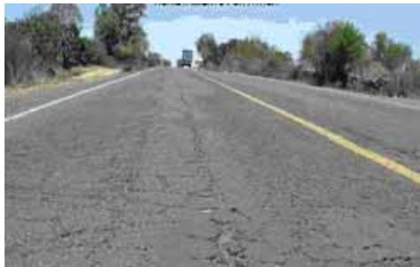
Fig. 20.- Agrietamiento por fatiga o envejecimiento.
