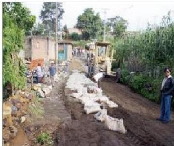
Fig. 40.- Distribución del conglomerante en forma manual colocando sacos de 50 Kg.
