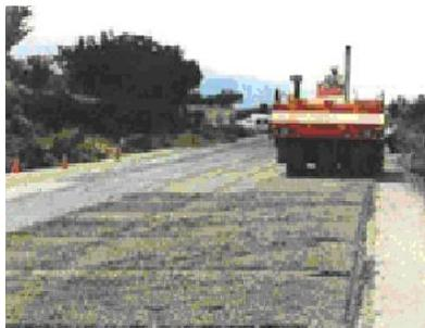
Fig. 51.- Juntas creadas en fresco a distancias cortas.
