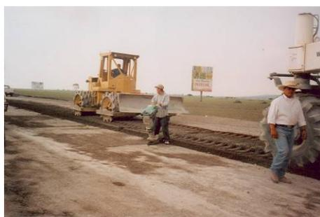
Fig. 36.- Compactación por medio de un rodillo pata de cabra.
