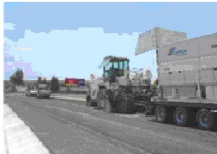
Fig. 49.- “Dosificadora de cemento” WM 1000 acoplada a la recuperadora WR 2500 S.
