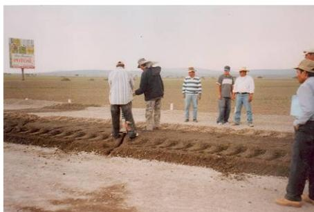
Fig. 35.- Elaboración de juntas transversales con una "quilla".
