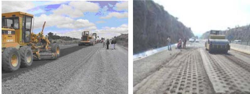
Fig. 66.- a) Afinamiento con una motoniveladora y b) compactación final con rodillo liso vibratorio.
