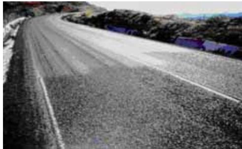
Fig. 11.- Exposición de agregados.
