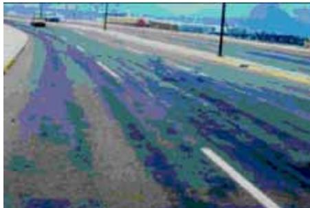
Fig. 9.- Exudación de asfalto.
