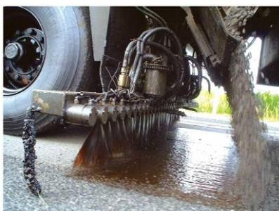
Fig. 38.- Colocación de riego de sello como protección del material recuperado.
