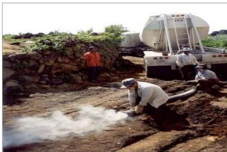
Fig. 41.- Dosificadores de cemento en polvo (carros dispersadores de un eje).
