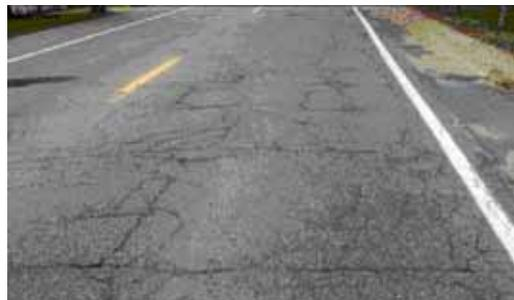
Fig. 18.- Fisura en malla.
