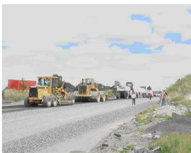
Fig. 37.- Afinamiento con motoniveladora.
