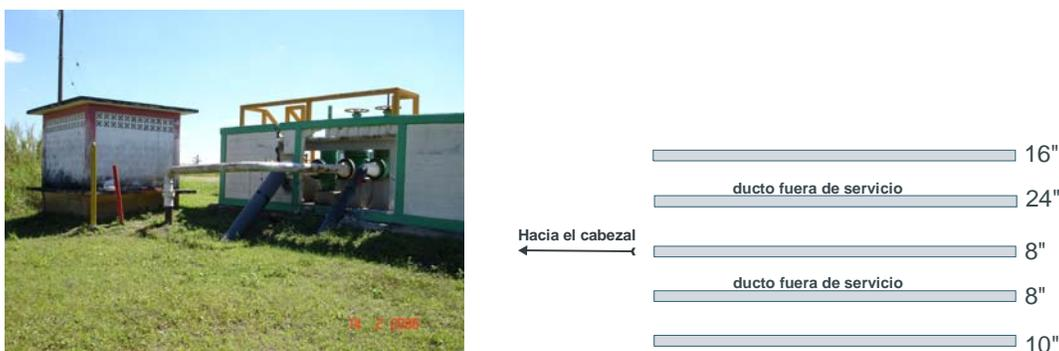
Figura 6.14. A) Cabezal a partir del cual se inicia el estudio de cinco ductos, B) Posición relativa de los ductos en área de estudio (información preliminar).
