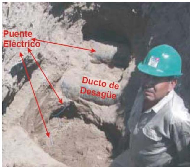
Fig. 6.11. Excavación realizada en el bordo sur del canal que confirma con exactitud de 20cm, la posición del puente eléctrico detectado con la tecnología desarrollada.
