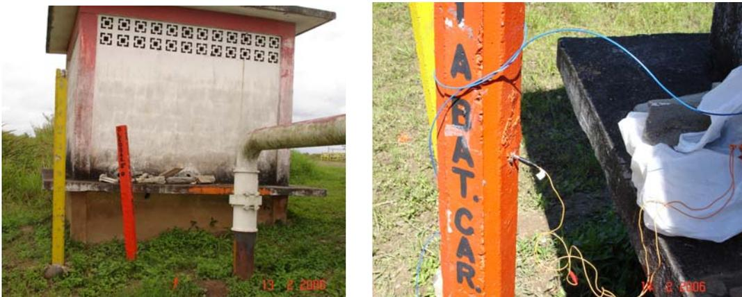
Figura 5.1 A) Poste de control típico (en color naranja) ubicado sobre un ducto B) Conexión de una Terminal del generador externo al poste de control de protección catódica.
