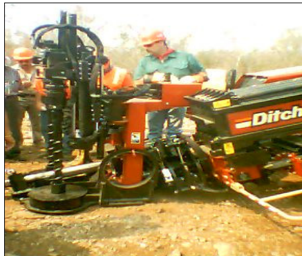
Anclaje de barras estabilizadoras
