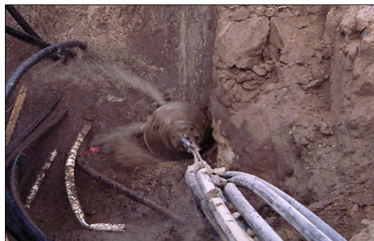
Preparación e introducción de ductos de barrenación
