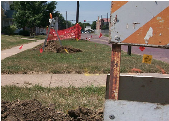
Confinamiento de la zona de trabajo
