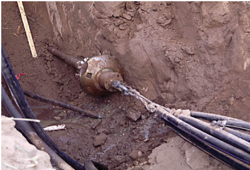
Colocación de ductos mediante retroensanchador de barril
