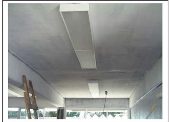
Pintura vinílica lavable en muros, columnas, traves y plafón    Luminaria fluorescente de 2 x 39 w
