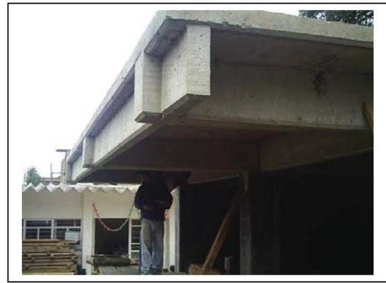
Losa y trabes coladas y descimbradas
