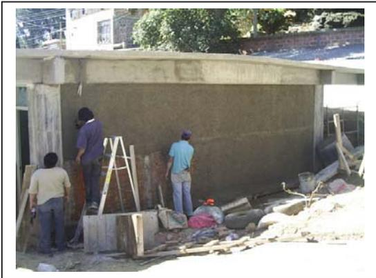
Aplanados exteriores con mortero cemento cal-arena 1:2:6 a plomo y regla, acabado con llana de madera
