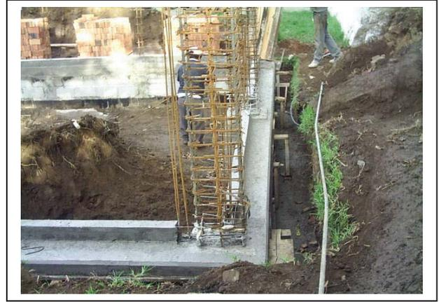
Murete de enrase en cimentación con tabicon de concreto 15 x 20 x 40 cm. Asentado con mortero cemento arena 1:5 ; cadena de concreto  $f'c= 250 \text{ kg/cm}^2$  de 14 x 15 cm. Y zoclo de concreto de 12 x 10 cm.
