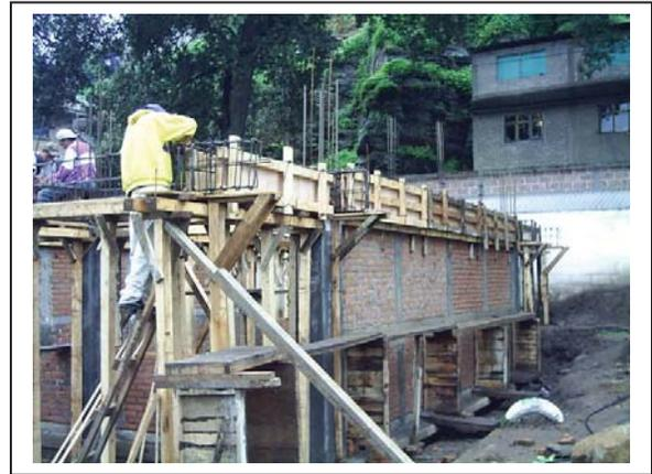
Armado de traves con acero de refuerzo  $f'y=4200$  kg/cm<sup>2</sup> con diferentes diámetros No. 5, No. 6, No. 3, incluyendo traslapes, ganchos y siletas
