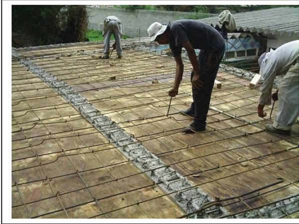
Armado de acero de refuerzo en estructura de losa
