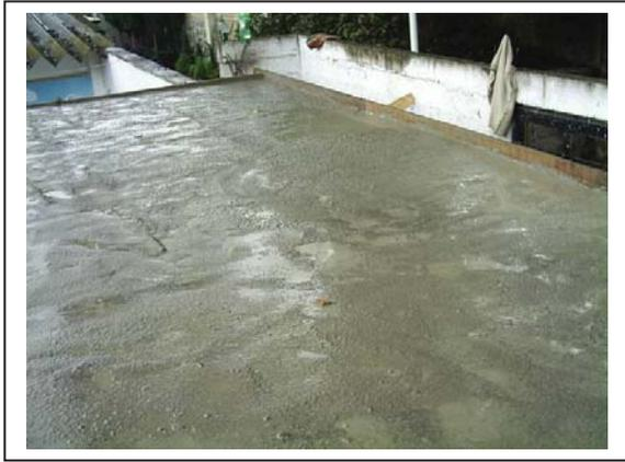
Colado de losa a base de concreto  $f'c = 250 \text{ kg/cm}^2$
