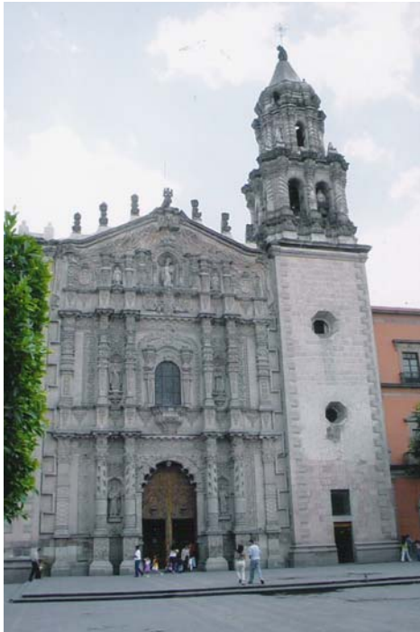
Imagen 44. Fachada principal Iglesia San Elías, SLP
