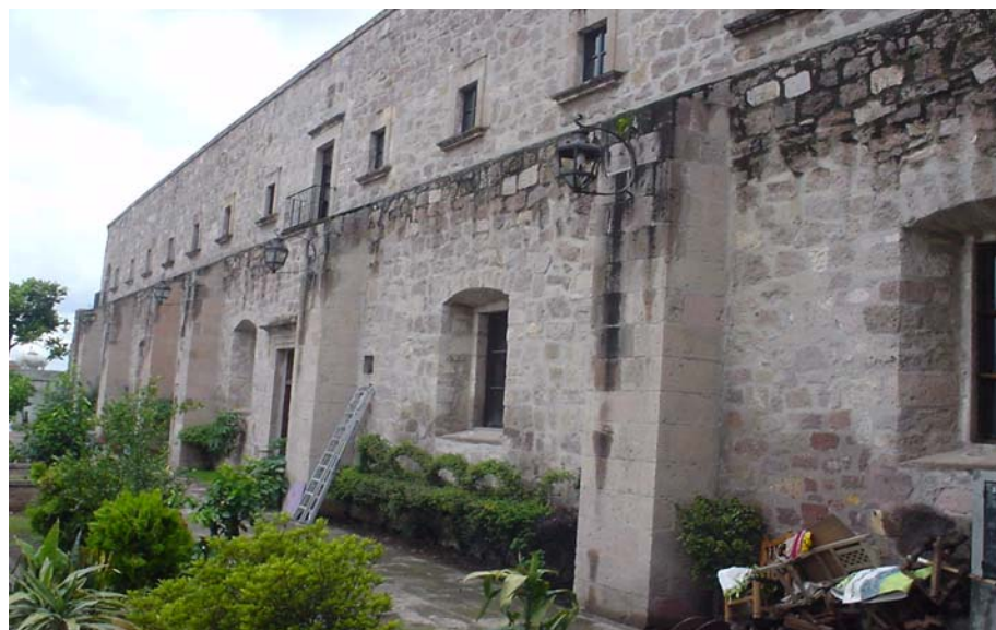
Imagen 72. Fachada poniente del convento
