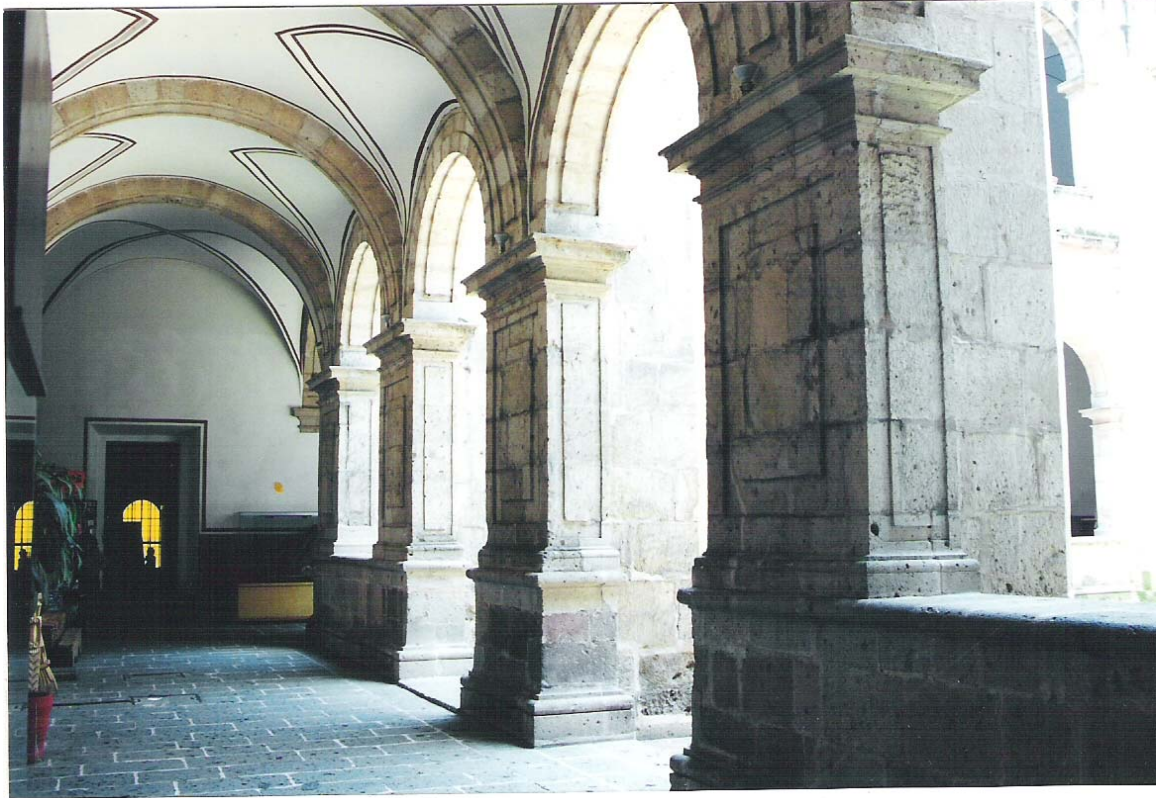
Imagen 19. Exconvento franciscano, actual Casa de las Artesanías de Morelia. Claustro y pilastras molduradas en sentido vertical.
