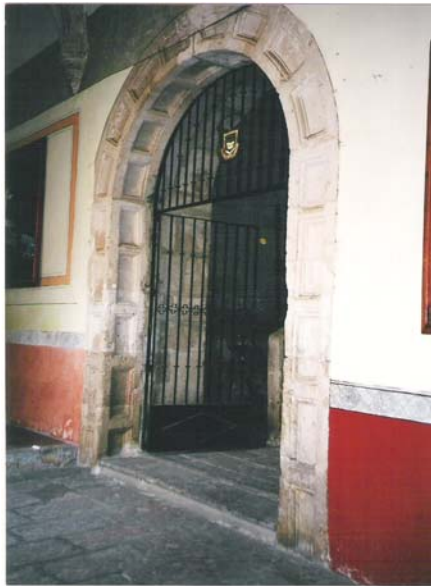
Imagen 30. Acceso al arranque de la escalera del claustro de San Agustín, con detalles ornamentales comunes en el siglo XVI, a base de casetones y molduras.
