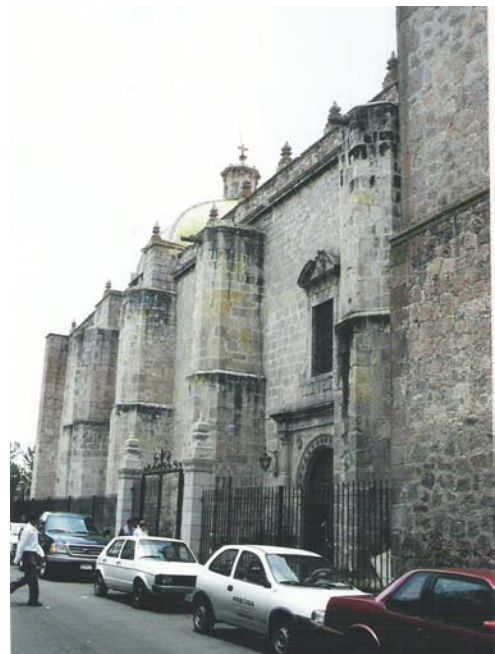
Imagen 24. Contrafuertes exteriores de la nave del templo agustino.
