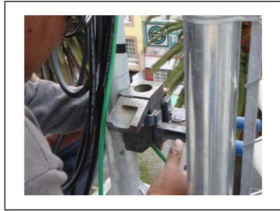
**FIJACION DE MOLDE A ESTRUCTURA METALICA      MOLDE CON CABLE
