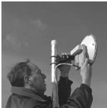
Fig. 2.14 Instalación de abonado LMDS.
