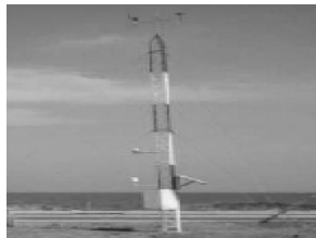
MONTAJE EN TORRE
