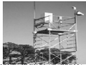
MONTAJE EN PLATAFORMA ALTA
