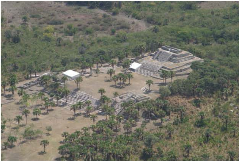
Figura 124.- Vista aérea de la Estructura 1, en la actualidad
