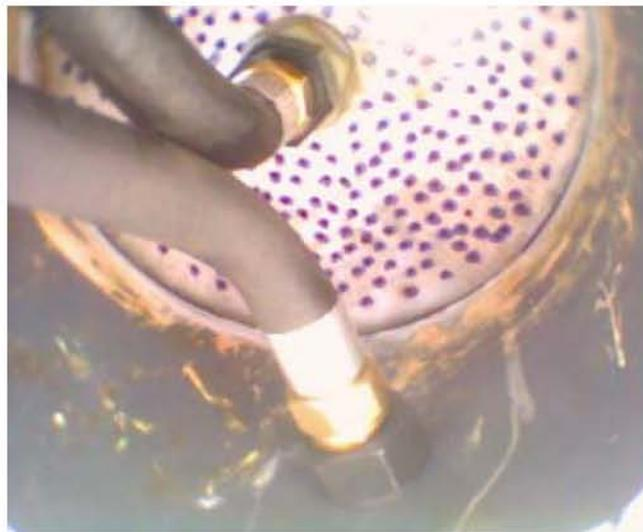
**Figura 3.13.** Sistema de alimentación de aire para retrolavado dentro del falso fondo.
