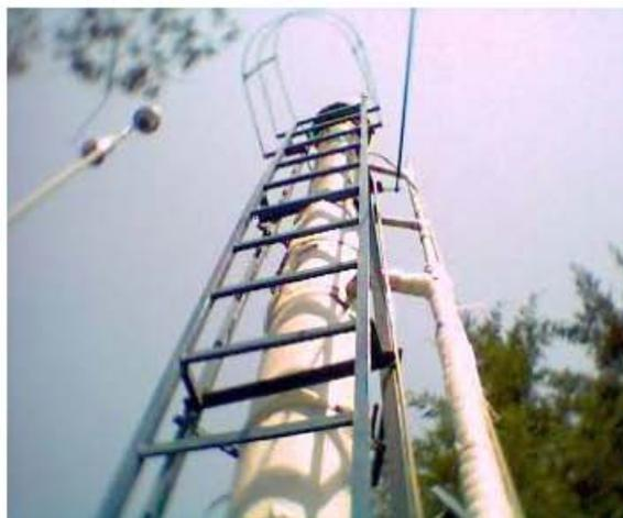
**Figura 3.8.** Escalera alojada a lo largo de todo el biofiltro y las tres salidas de descarga. El biofiltro cuenta con tres salidas de agua (efluente) en la parte superior del mismo, localizadas a 3.20, 3.75 y 4.45 m de altura (figura 3.8) a partir del anillo que soporta todo el biofiltro. La primera salida es el efluente de operación normal del biofiltro, la siguientes 2 salidas son para desalojar el agua en la operación de retrolavado.
