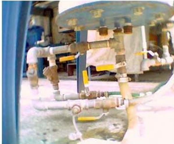
**Figura 3.14.** Sistema de alimentación de agua para retrolavado.
