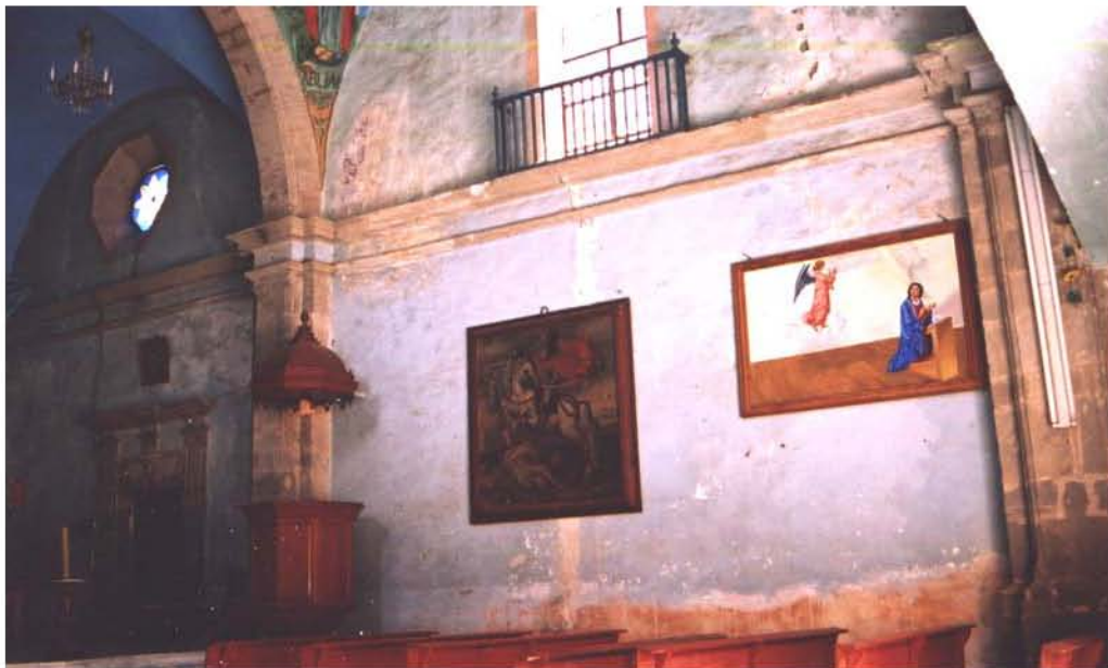
Imagen 42. Muro sur de Santa María
