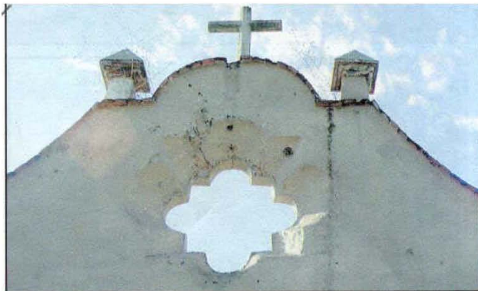
Imagen 4. Ventana en el arco de entrada al atrio del convento
