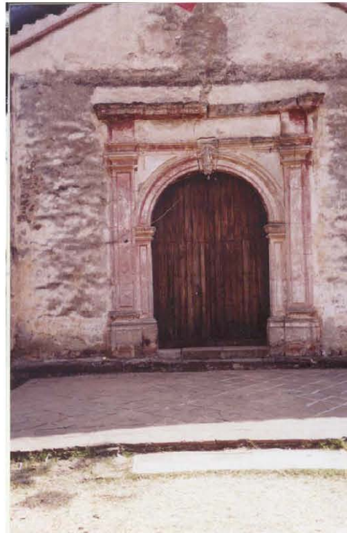
Imagen 28. Puerta y fachada de San Andrés
