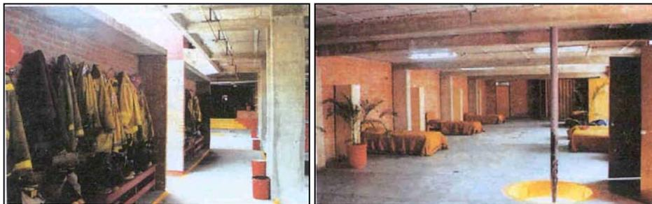
En estas imágenes se observa el sistema de entresijo de vigueta y bovedilla empleado en la estación de Aguascalientes. El claro corto entre columnas es de 4.5 m (viguetas para las bovedillas) y de 7.5 en el claro largo.
